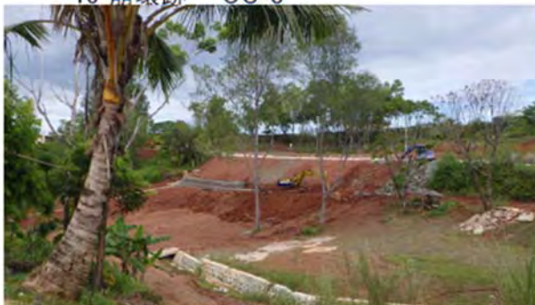
18 対策工事中 L-4
