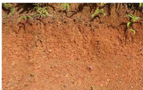
図 1.2.4 コクサイ変電所基礎の盛土 (風化した火山岩土壌が盛土材)
