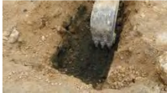
トレンチ掘削中(深度 1.5m)
