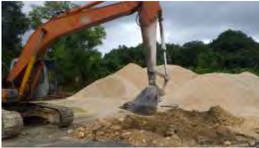
トレンチ掘削中
