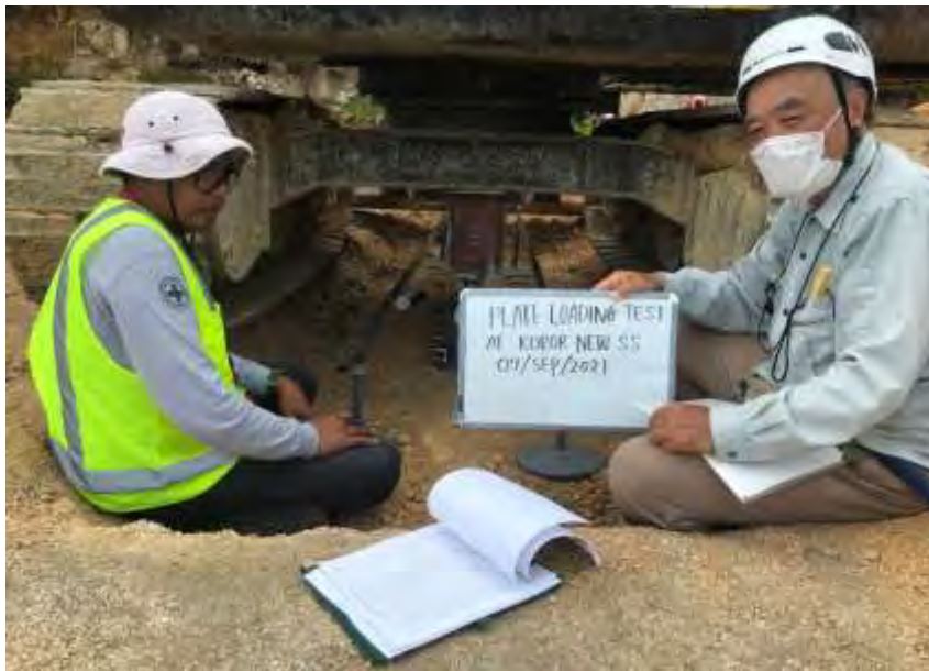
上部は反力となる重機。試験装置のセット完了
