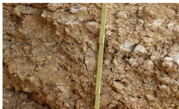
図 1.2.5 コロール変電所の盛土 (採石した石灰岩礫と砂が盛土材)
