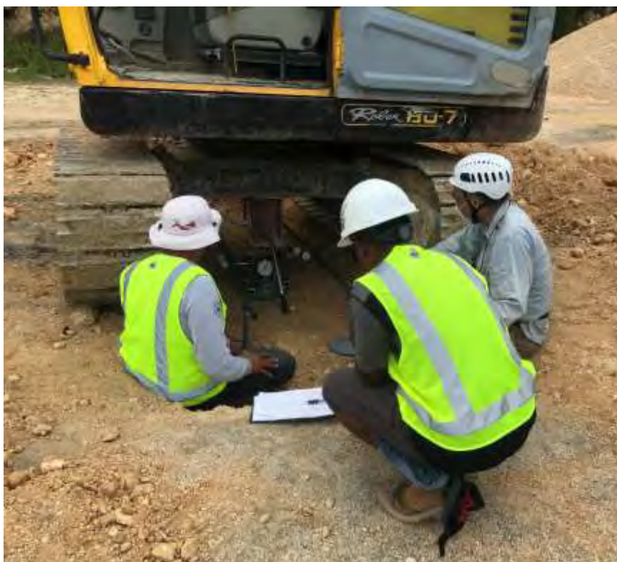
平板載荷試験 計測中
