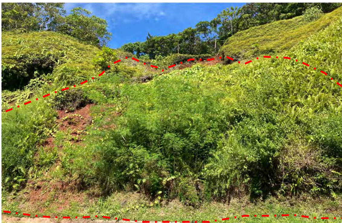
図 2.1.3 地すべり地（写真は L-2） 電柱は反対側に設置する
