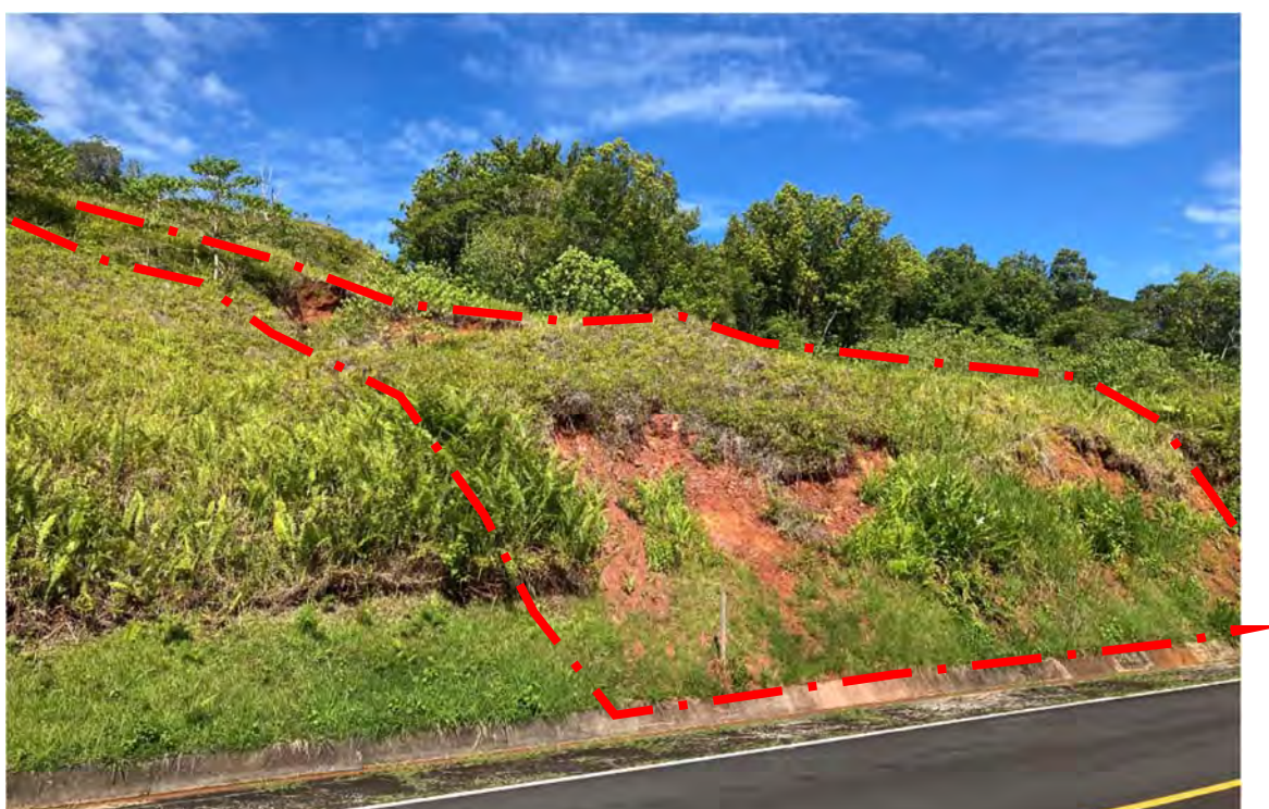
図 2.1.4 地すべり地（写真は L-3） 電柱は反対側に設置する
