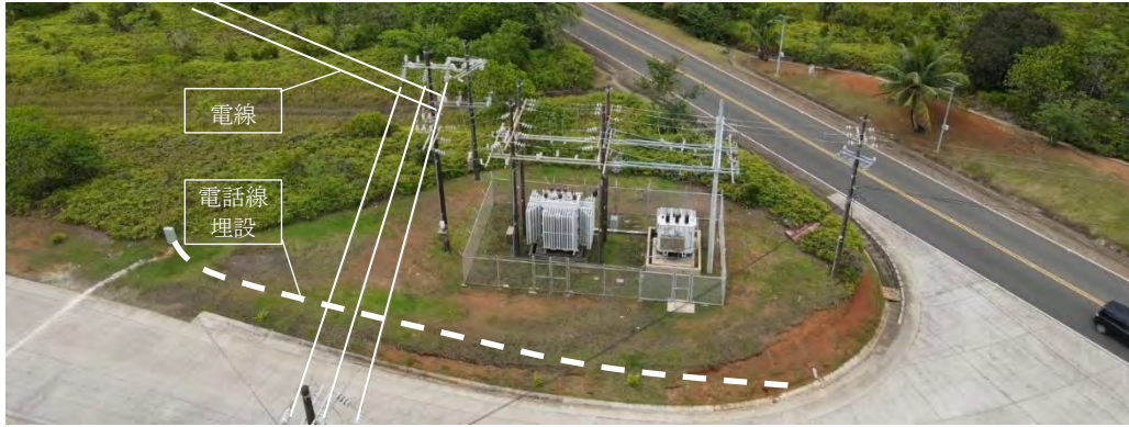
既存コクサイ変電所と建設予定地全景
