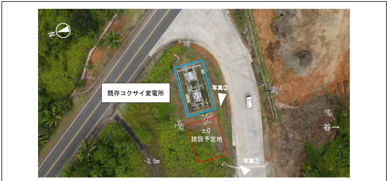
既存コクサイ変電所全景と建設予定地
