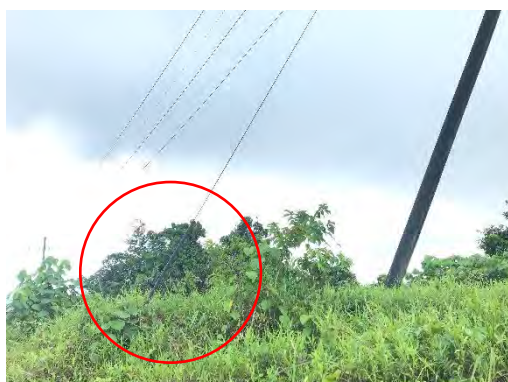
図 2-1-4.2 ツタガードが機能している状況（支線用ツタガード）
