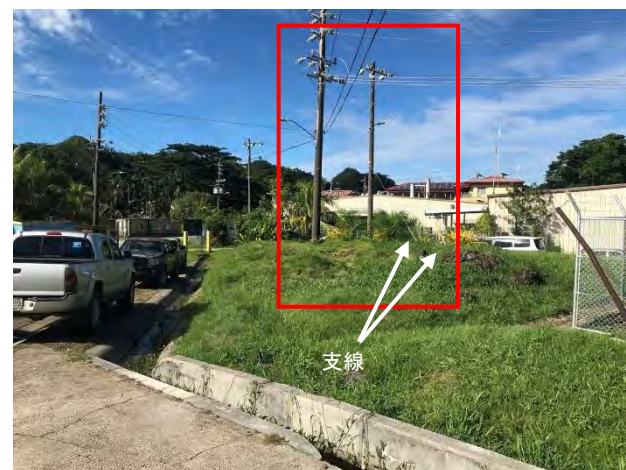
写真② 増設用地全景（南側から撮影）
