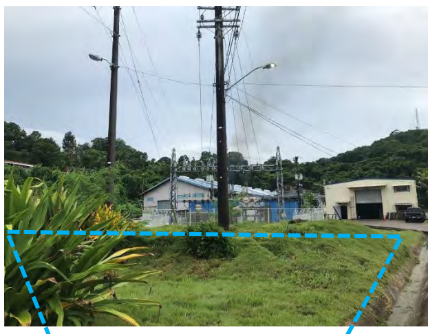
写真① 増設用地全景（北側から撮影）
