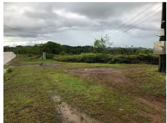
写真② 増設用地全景（南東側から撮影）
