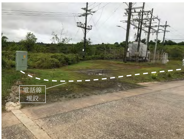
写真① 増設用地全景（南西側から撮影）
