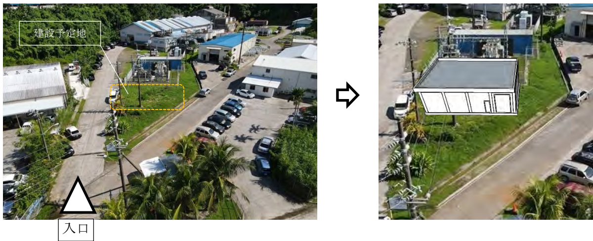
既存マラカル発電所の全景と変電所建設予定地
