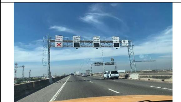
高速道路での速度警告及び速度取締り設備
