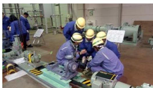
ポンプ分解点検研修（実習）
