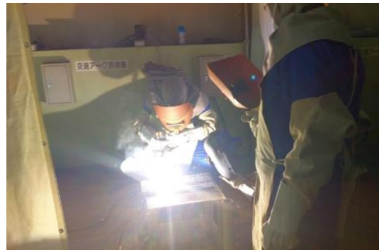
溶接施工研修（実習）
