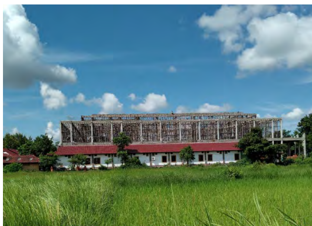
寺院別棟（建設中）
