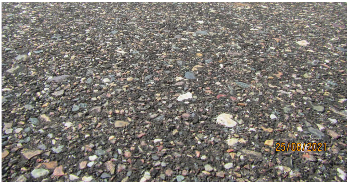
図 4.21 誘導路の舗装状況
