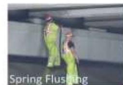
Spring Flushing 支承部洗浄
