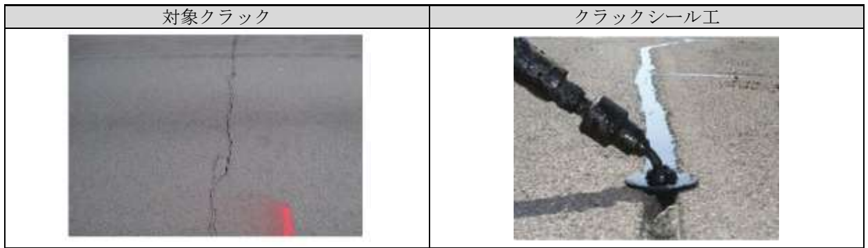
図 8.14 クラックシール工 144
