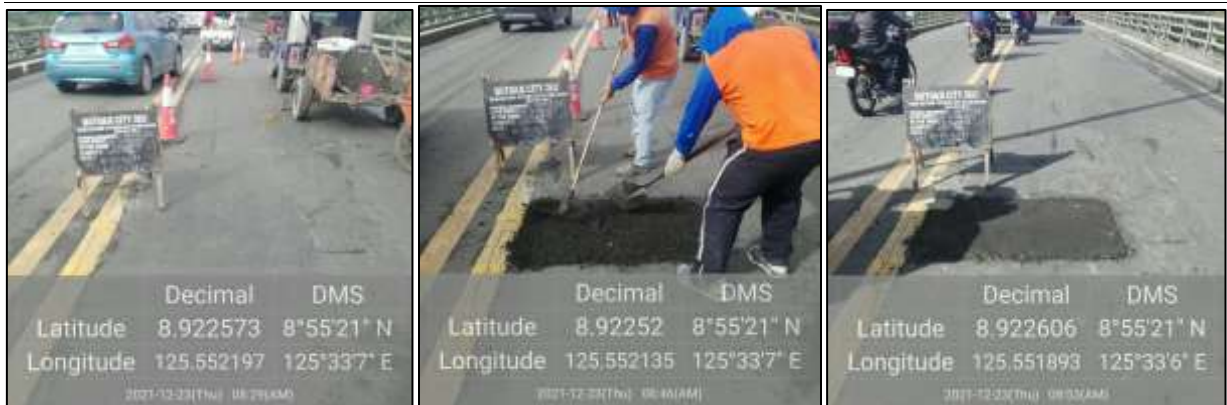
図 14.20 ディオスダド・マカパガル橋におけるポットホール補修の実施状況
