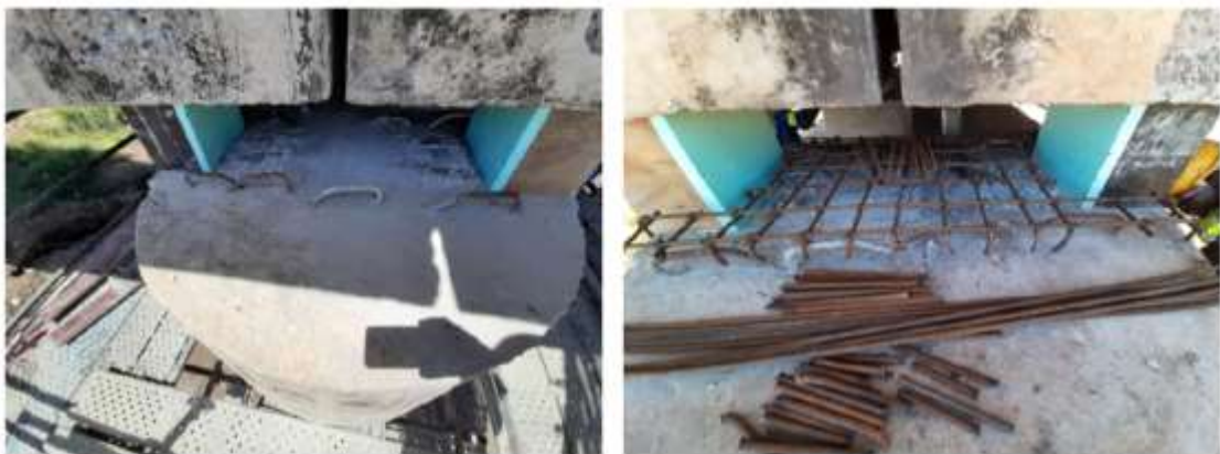
Montagem de armadura para plinto inferior e execução de cofragem - pilar 14
