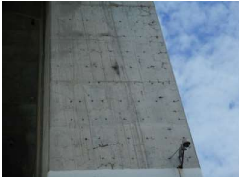
図 14.8 ASR によるクラック状況
