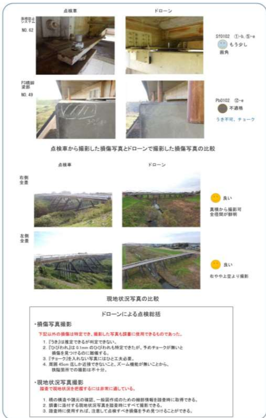
図 7.35 点検新技術マッチング及びロボット点検 (2/2) 113
