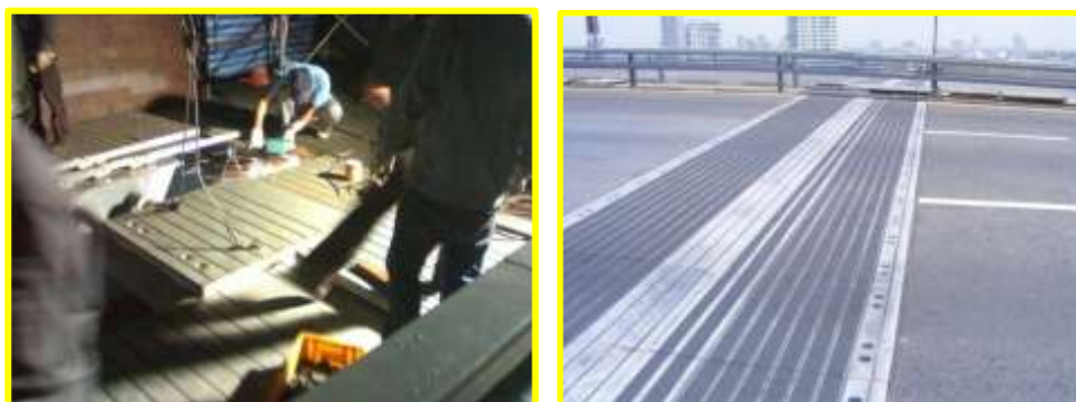
図 14.39 伸縮装置の交換 (2010年)
