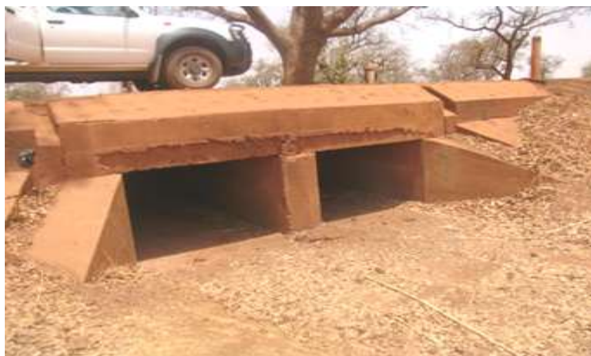
図 12.7 その他（カルバート橋など）の事例
