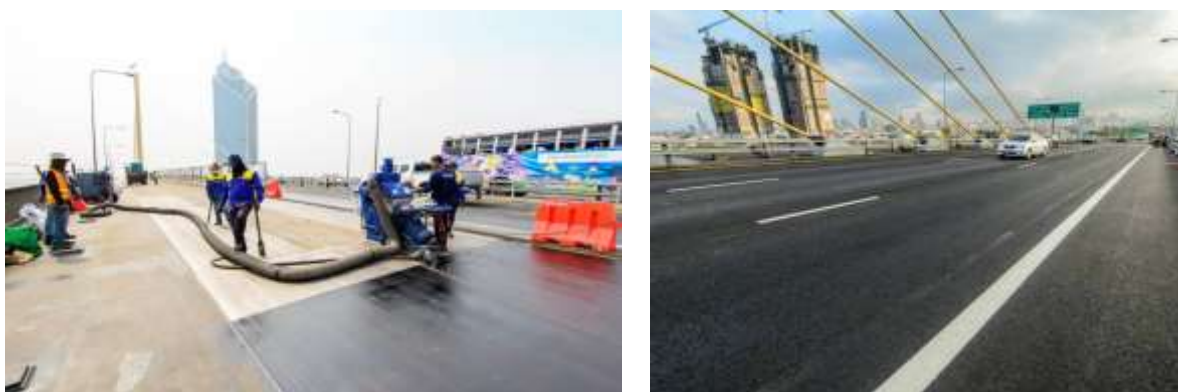
図 14.43 舗装の打ち換え
