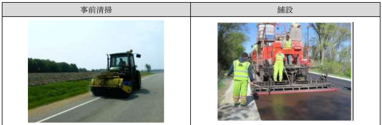
図 8.16 マイクロサーフェス工 146
