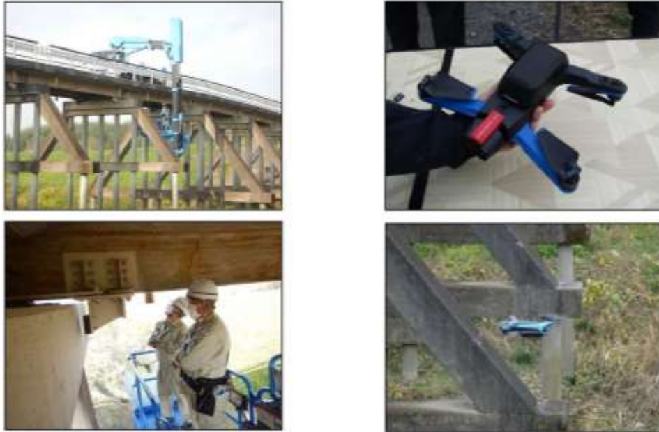
橋梁点検車による近接目視点検状況及びドローンによる点検状況
