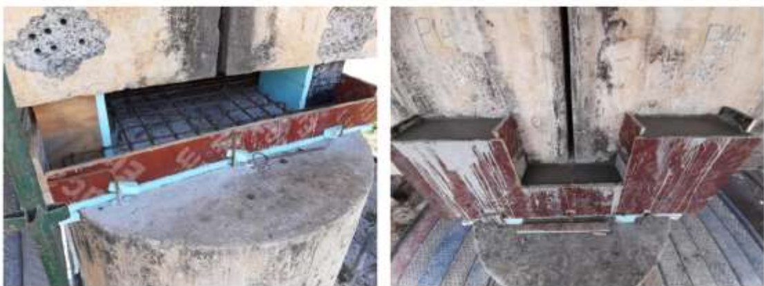
Montagem de cofragem e betonagem de plintos inferiores e superiores - pilar 14
