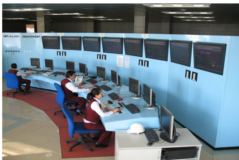
図 3-29 ボイラ制御システムの更新状況
