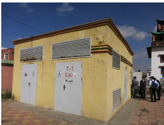
図 3-19 リングメインユニットが設置された配電塔の例
