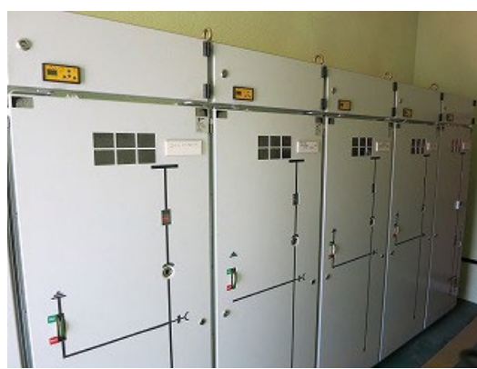
図 3-19 リングメインユニットが設置された配電塔の例
