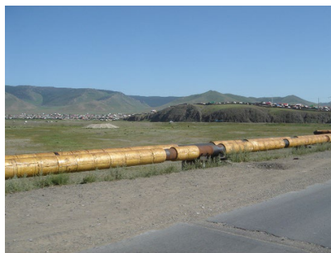
保温補修中の架空配管
