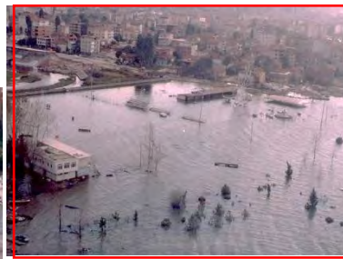
(7) 空から見た水没状況
