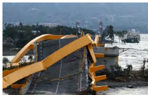
図 3-1-1 落橋したパル第四橋
