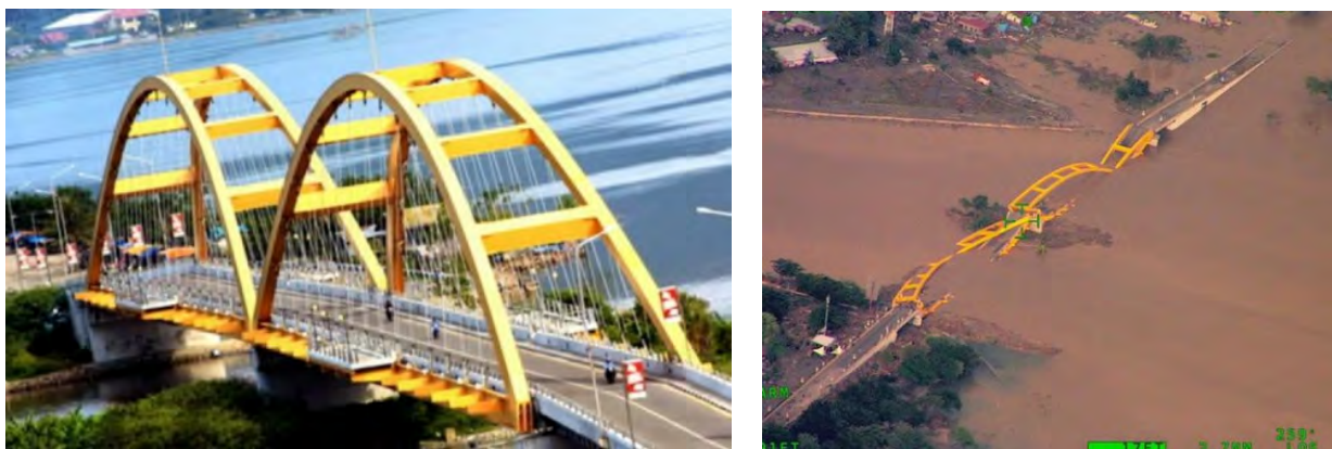
図 1-2-2 パル第四橋崩壊前（左）、崩壊後（右）
