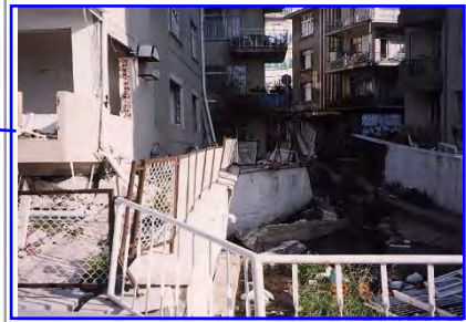
(2) 陸上に現れた右横ずれの地表断層
