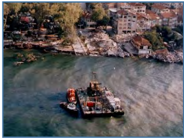
(4) 空から見た地盤の流失
