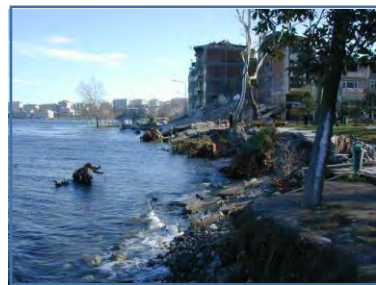
(5) 海岸から見た地盤の流失
