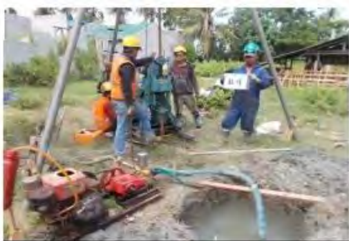
ボーリング調査
