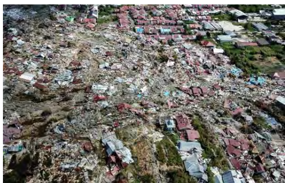
Petobo の南西端集積域末端（被災状況；倒壊した家屋が集積している状況）
