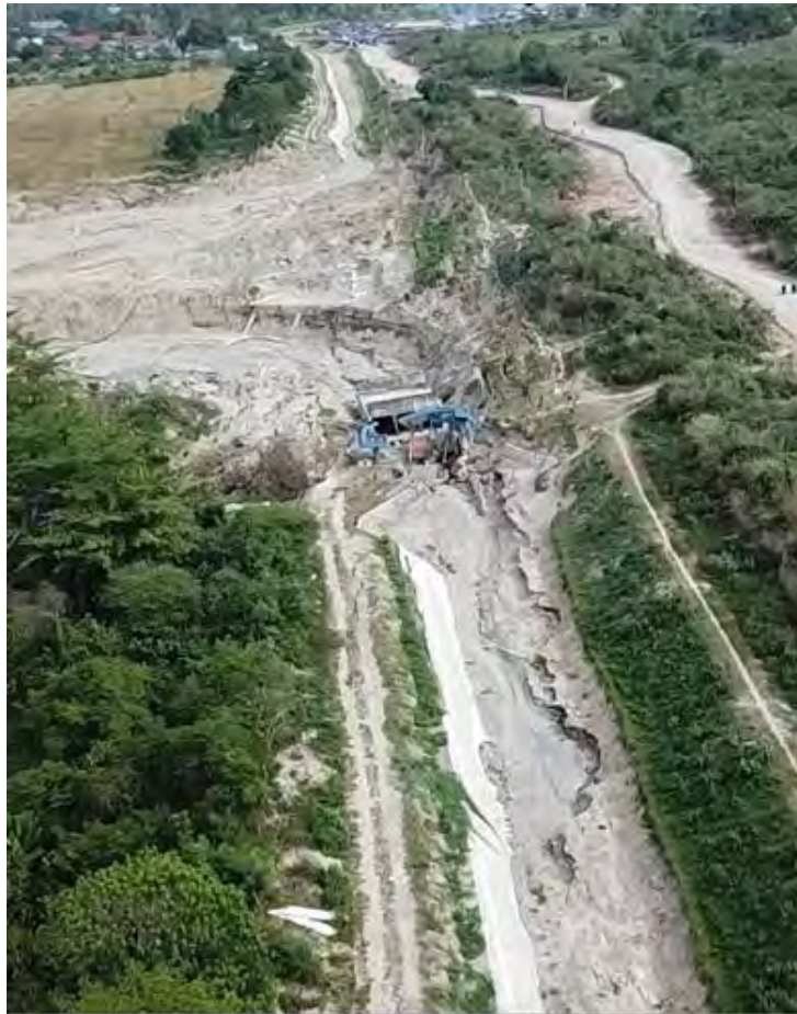
Sibalaya 地すべりの頭部鳥瞰 灌漑水路と頭部滑落崖が完全に一致している。流動した水路堰堤により、水路の水もすべて流出し、頭部付近は土砂が流出した。写真中央の水門施設も大きく被災している
