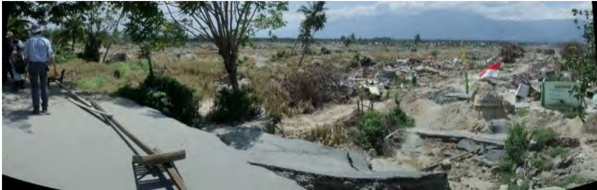
Petobo の頭部滑落崖 比高差 3～5mの崖が出現し、アスファルト道路が無くなっている。
