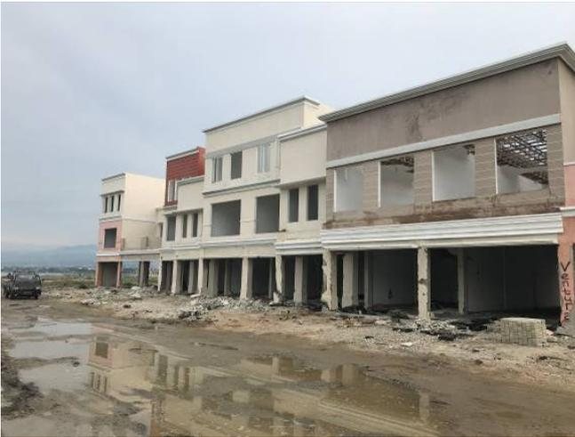
津波浸水（沿岸部から 100m～450m）による建物の被害（パル湾右岸側）
