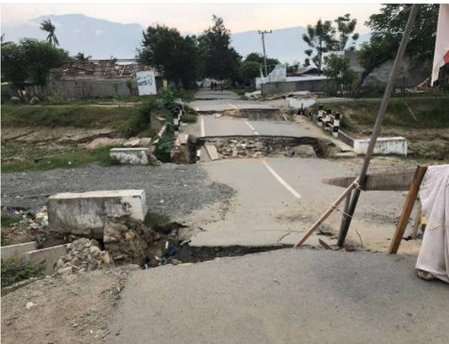
液状化地すべりによって破壊された道路（パル市）
