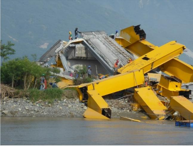
地震によりパル川河口に位置するパル第四橋が落橋・崩壊
