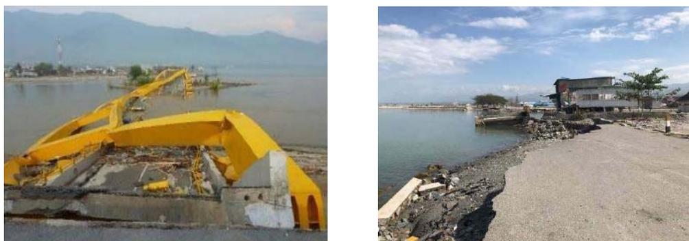
図 2-9 津波被害状況（左：パル第四橋の倒壊、右：Palu 湾沿岸の地すべり沈下）
