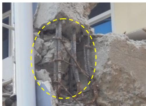
損傷により露出した柱配筋
