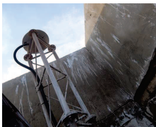
ダカール港に設置されている電子基準点
