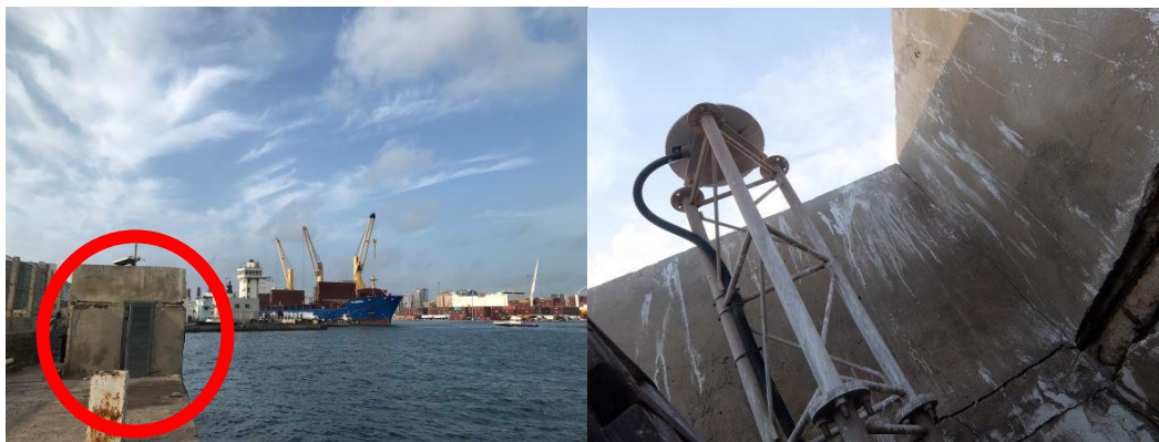
コンクリートで覆われた小さな施設(赤○)が電子基準点 出典：調査団
