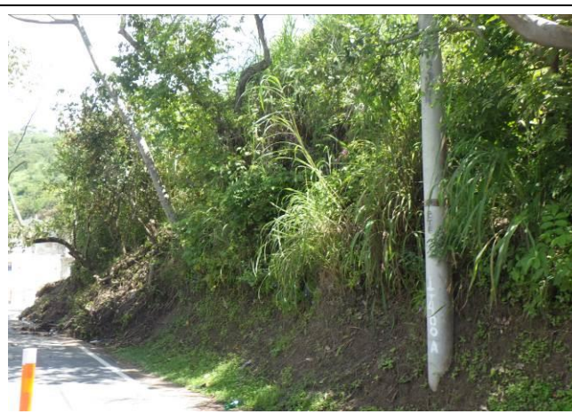
Empuje hacia la carretera al final del desprendimiento que se produjo el 10 de septiembre de 2021. Tomado desde el punto de partida (16 de septiembre de 2021)
