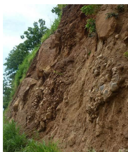
Talud de sedimentos con grandes gravas a cantos rodados, parcialmente saliente. (Abril 2021)
