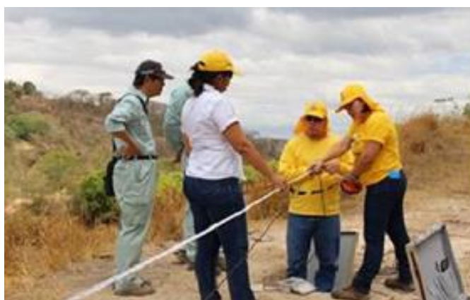
Instalación de medidores de nivel de agua autorregistrados en pozos de monitoreo de nivel de agua subterránea por parte de la DACGER (julio de 2017)
