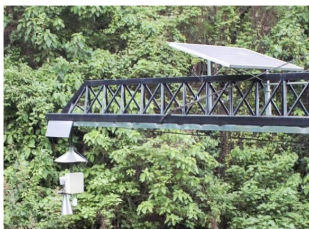
Instalación de medidores de nivel de agua por radiofrecuencia y cámaras de CCTV (abril de 2021)
