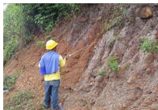
Se pulverizaron alguicidas para el suelo y se mezcló papel blanco para aumentar la viscosidad y controlar el flujo del material pulverizado. Como resultado, la zona rociada es blanca y visible. (Octubre 2021)
