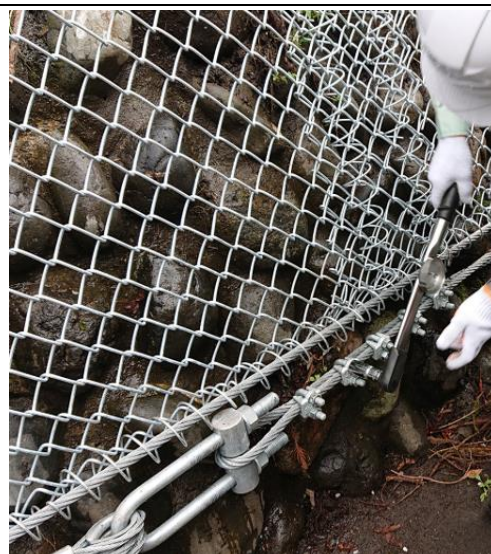
Observación de la inspección de finalización de la red de protección contra desprendimientos de rocas de alta energía prevista para el tramo en el que no hay separación entre el talud y la carretera (Musashi-Itsukaichi, Tokio), con la participación del experto principal y un asistente de gestión de la construcción de El Salvador (en ese momento, estudiante de JICA en Tsukuba en el curso de maestría sobre terremotos y tsunamis) (abril de 2021)
