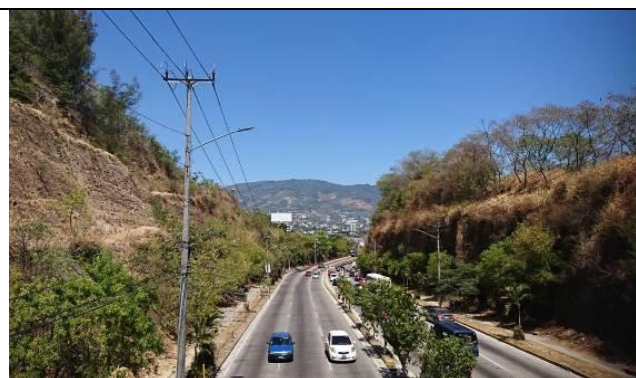
Toma aérea DACGER con dron, vista panorámica, fuente de desprendimiento de rocas a ambos lados de la ladera (julio de 2021)
