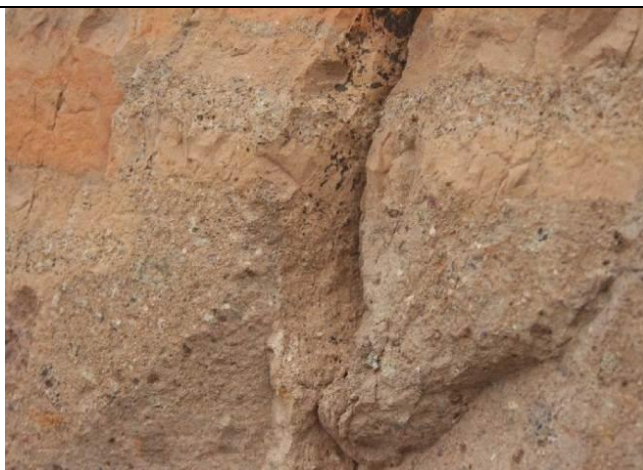
Roca blanda con baja resistencia a la intemperie y a la erosión por el agua de lluvia: planificación y diseño de pulverización con arena mezclada con fibras largas y cemento y colocación de láminas para la cimentación (4 de junio de 2021)
