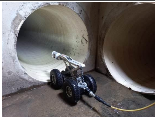
Inspección de tuberías enterradas con cámara CCTV robotizada (mayo 2021)
