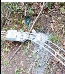
Instalación de vallas de protección contra desprendimientos de rocas de alta absorción de energía en las zonas donde se producen desprendimientos de rocas, para proteger los senderos y las calzadas (febrero de 2020)
