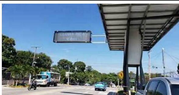
Paneles de aviso de inundaciones y desprendimientos en el carril norte (abril de 2021)
