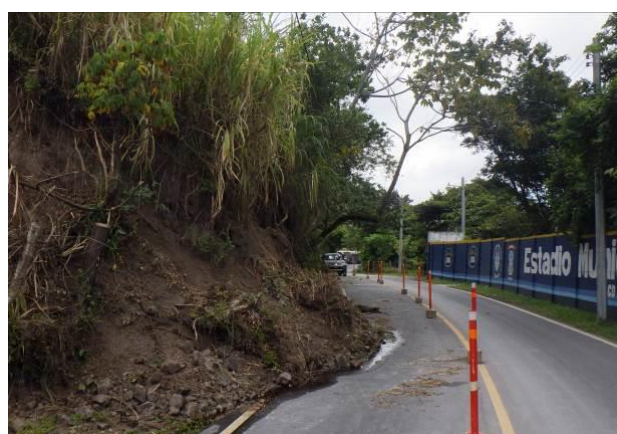
Extrusión del extremo del desprendimiento en la carretera, que se produjo el 10 de septiembre de 2021. Tomada desde el final de la carretera (16 de septiembre de 2021)
