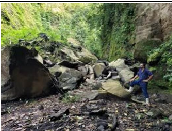
La sección aguas arriba del río, este tramo está cubierto de cantos rodados. Se planificó y diseñó un vertedero de control de la erosión de suelo cemento aguas abajo del vertedero. (Octubre 2021)
