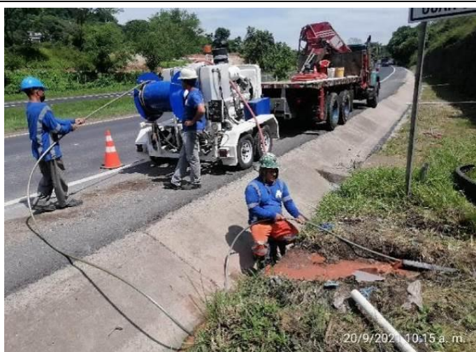
Se observa la limpieza por inyección de agua de los desagües subterráneos existentes y el drenaje de las aguas turbias resultantes del paleosuelo marrón (septiembre de 2021).
