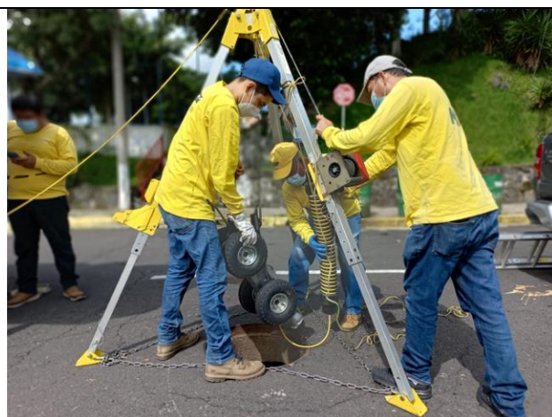
Inspección de tuberías enterradas con cámara CCTV robotizada (mayo 2021)
