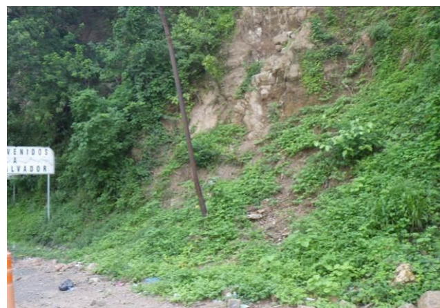
Vista panorámica de la situación del talud, al fondo de la foto, hay una nueva zona que colapso en septiembre de 2021. (Septiembre 2021)
