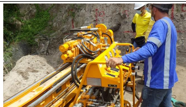
緊急地下水排除ボーリング、写真の機材は経済社会開発無償で供与されたロータリーパーカッションドリル (2021 年 10 月 14 日)
