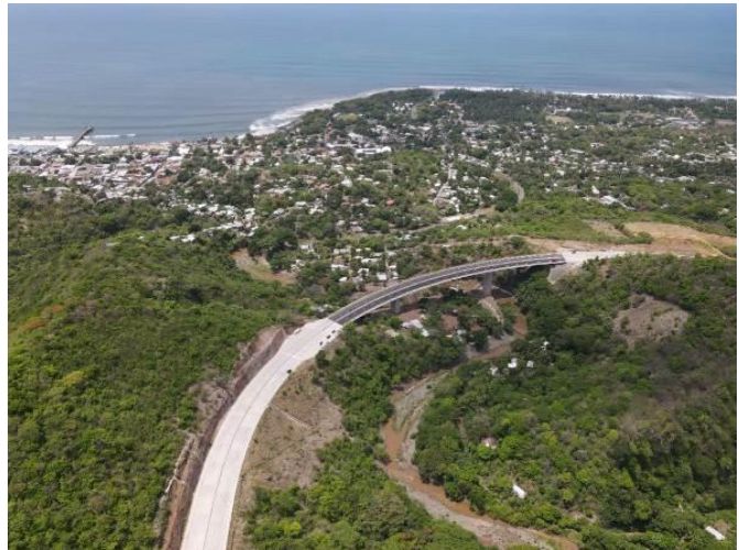
DACGER によるドロン空撮、当該斜面はサーフシティ橋よりも写真手前の起点側、写真奥にリベルタ港と海岸を望む、河川はチマラ川 (2021年5月)
