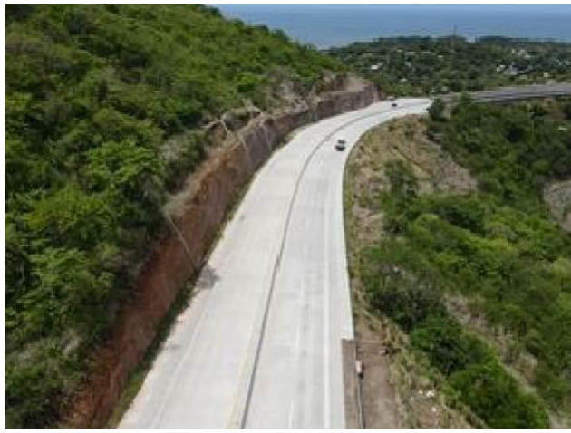
DACGER によるドロン空撮、 起点側からサーフシティ橋方向を望む (2021年5月)
