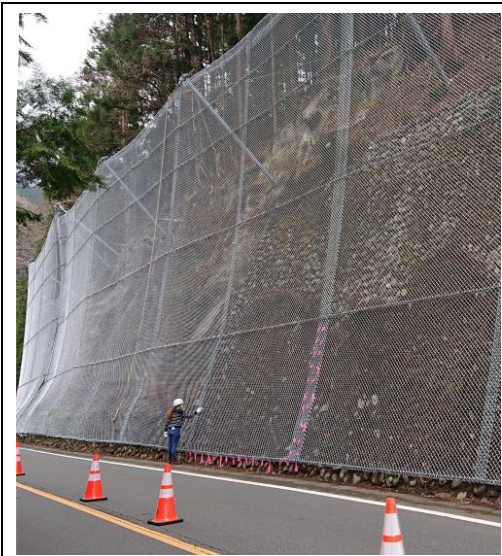
斜面と道路に離隔が無い区間に計画した、高エネルギー吸収型落石防護網の竣工時検査の見学(東京都武蔵五日市)主任専門家とエルサルバドル人施工管理補助員(当時、JICA つくば滞在、地震・津波マスターコース留学生)が参加 (2021 年 4 月)
