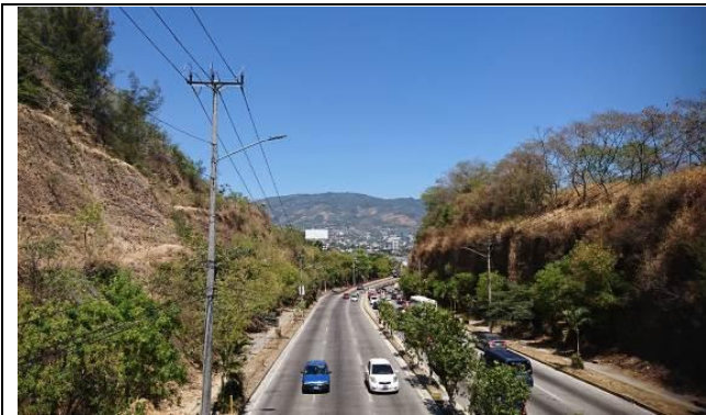
DACGER によるドロン空撮、全景、両側の斜面伴に落石発生源 (2021 年 7 月)
