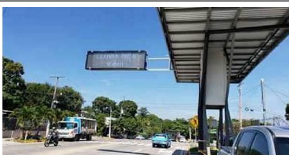
北方向車線の洪水・土石流警報情報板 (2021 年 4 月)
