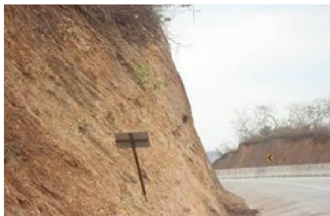
34 キロポスト付近、斜面には赤土砂が分布し降雨による侵食・濁水が発生しやすい状況にある (2021年4月)
