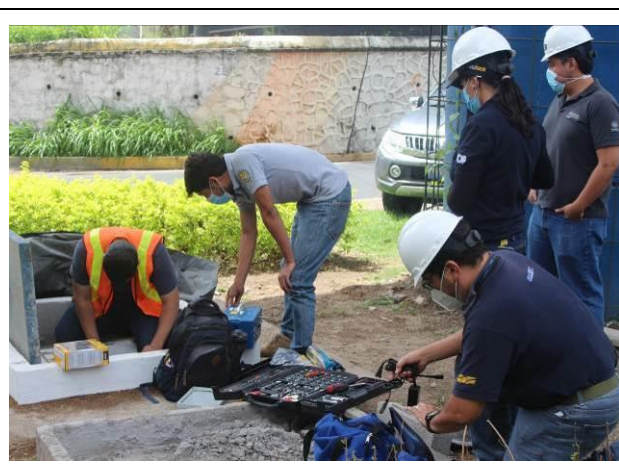
橋脚部の地盤に設置した地震計の維持・管理 (2021 年 7 月)
