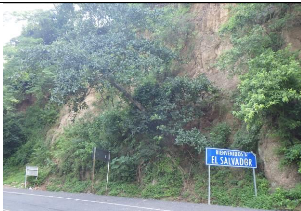
崩壊土石および新たな崩壊部 (2021 年 9 月)
