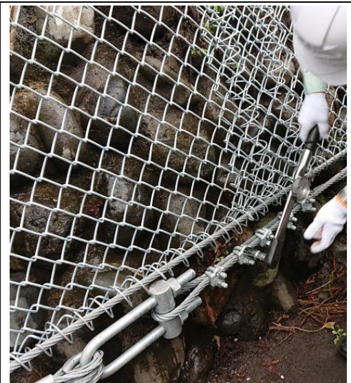
斜面と道路に離隔が無い区間に計画した、高エネルギー吸収型落石防護網の竣工時検査の見学(東京都武蔵五日市)主任専門家とエルサルバドル人施工管理補助員(当時、JICA つくば滞在、地震・津波マスターコース留学生)が参加 (2021 年 4 月)
