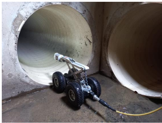
埋設管ロボット CCTV カメラによる検査(2021 年 5 月)
