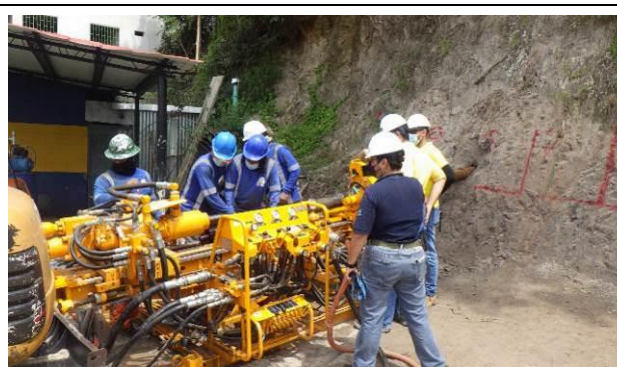
緊急地下水排除ボーリング、写真の機材は経済社会開発無償で供与されたロータリーパーカッションドリル (2021 年 10 月 14 日)
