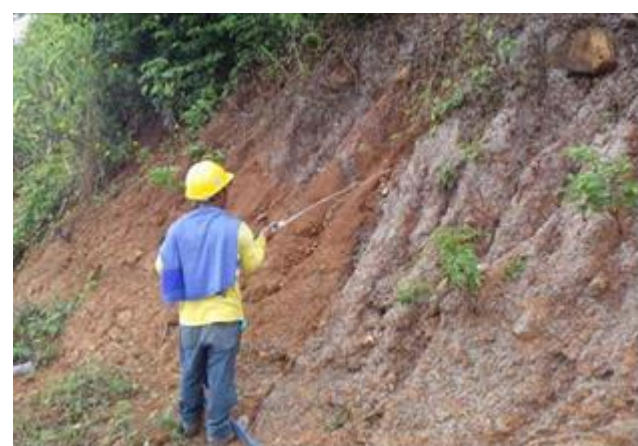
土壌藻類剤吹付状況、粘性を高め吹付材の流下を抑制するため白紙類を混入した。このため吹付部は白色を帯び、視認できる。(2021年10月)
