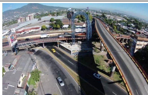
DACGER によるドロン空撮、空港方面の国内国道 5 号線 (RN5) の起点、高架橋 2 層、地上道路、アンダーパスからなる 4 層構造(2017 年 10 月)
