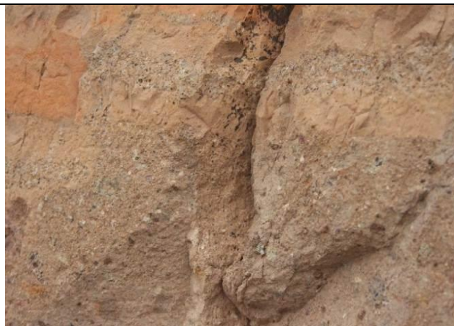
軟質岩で風化耐性が弱い、雨水での侵食も認められることから長繊維・セメント混入砂吹き付けと緑化基礎シートの敷設を企画、設計(2021年6月)
