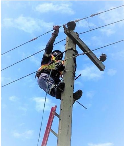
図 5-4.14 破損アームの撤去
