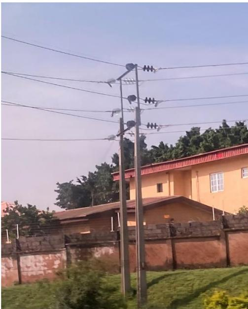
図 5-6.10 アングルによる電柱の嵩上げ
