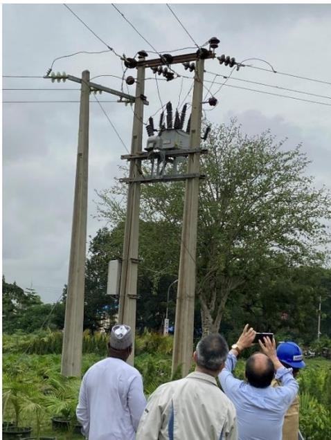
図 5-3.1 33kV リクローザ
