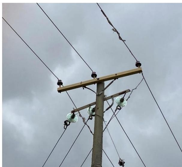
図 5-6.13 11kV 電線の断線修理
