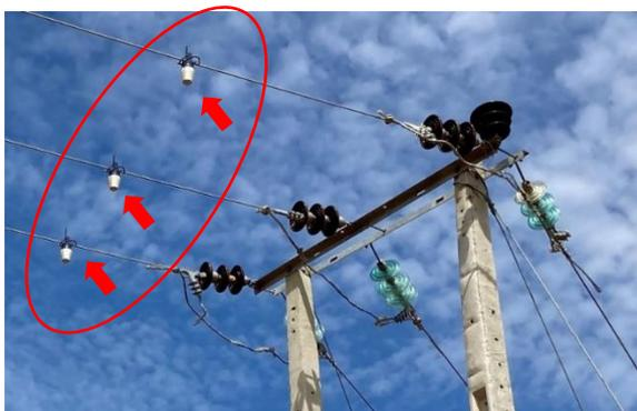
**既設 33kV 配電線 事故電流表示器(FCI)の設置状況**
