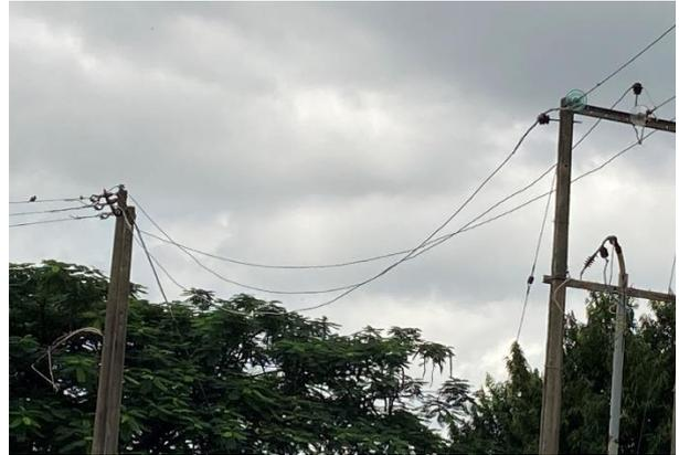
図 5-6.9 電線の大きな緩み
