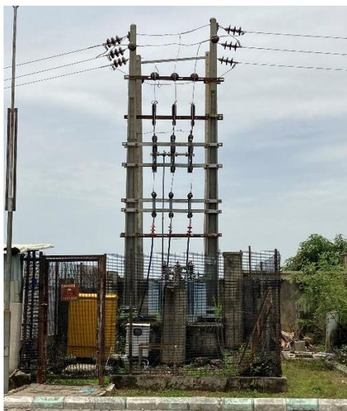
図 5-6.1 地上設置変圧器柱
