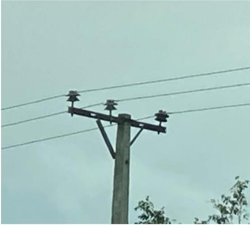
図 5-6.3 直線線路の標準装柱
