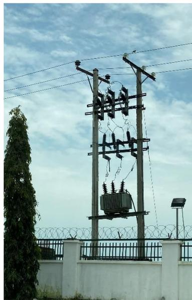
図 5-6.2 柱上設置変圧器
