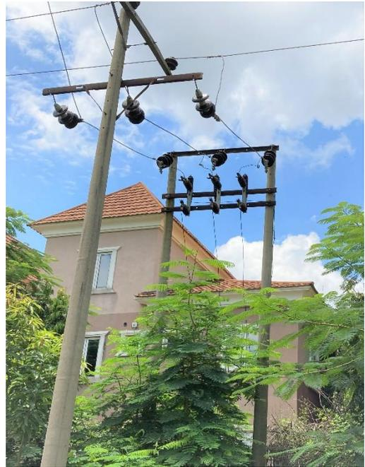
図 5-6.18 導線で直結された 33kV 変圧器
