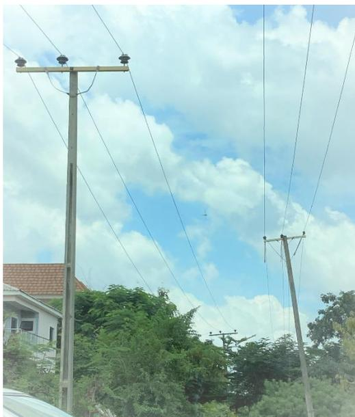
図 5-6.19 11kV 電柱の 33kV 線路側への傾斜
