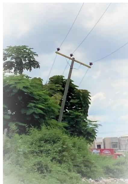
図 5-6.20 33kV 電柱の傾斜
