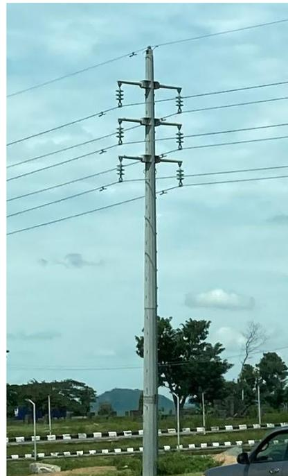
図 5-6.6 送電線仕様の 33kV 線路
