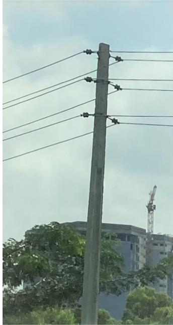
図 5-6.7 新しいタイプ（装柱）の低圧電柱
