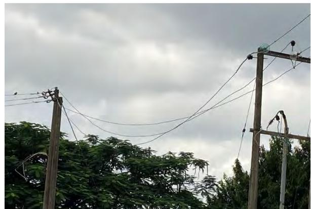
図2 電線の大きな緩み
