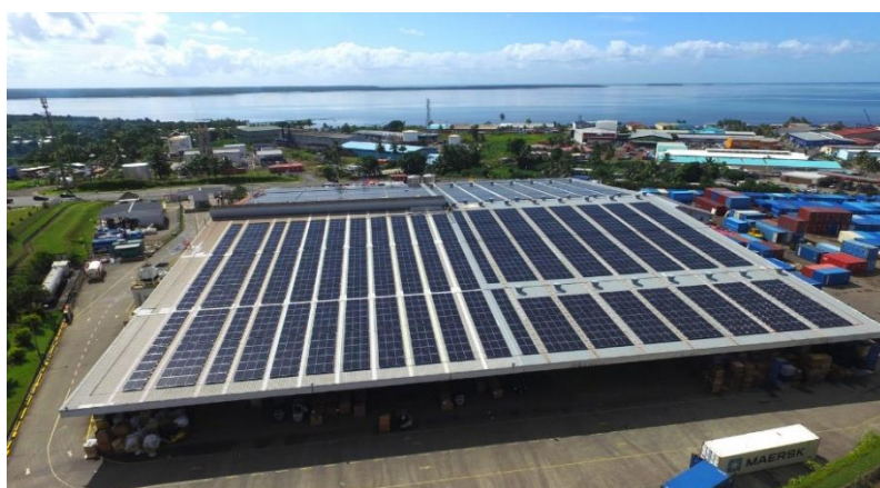
図 7-1 1.1 MW 屋根置き太陽光設備事例（スバ市内）
