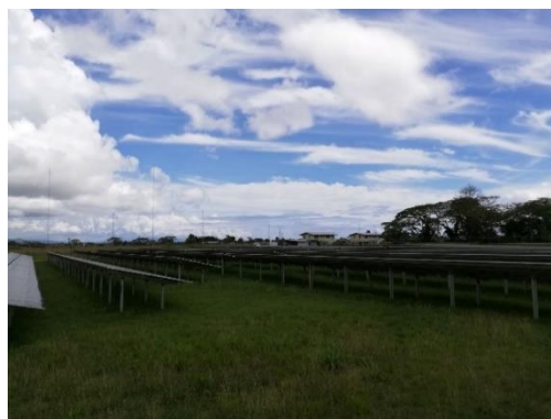
パネル設置状況 2
