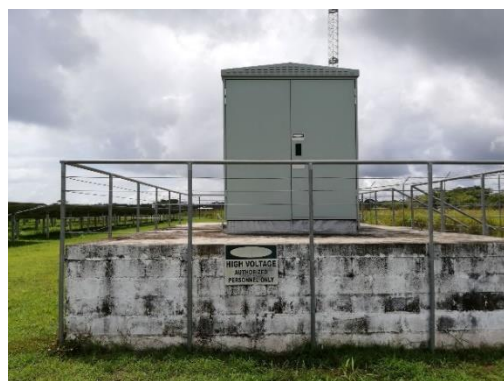
変圧器設置状況
