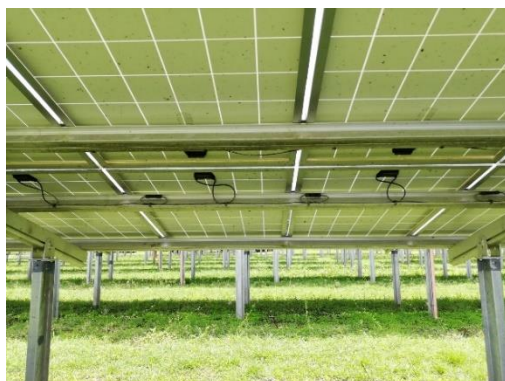
パネル下部状況
