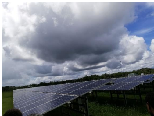
パネル設置状況 1
