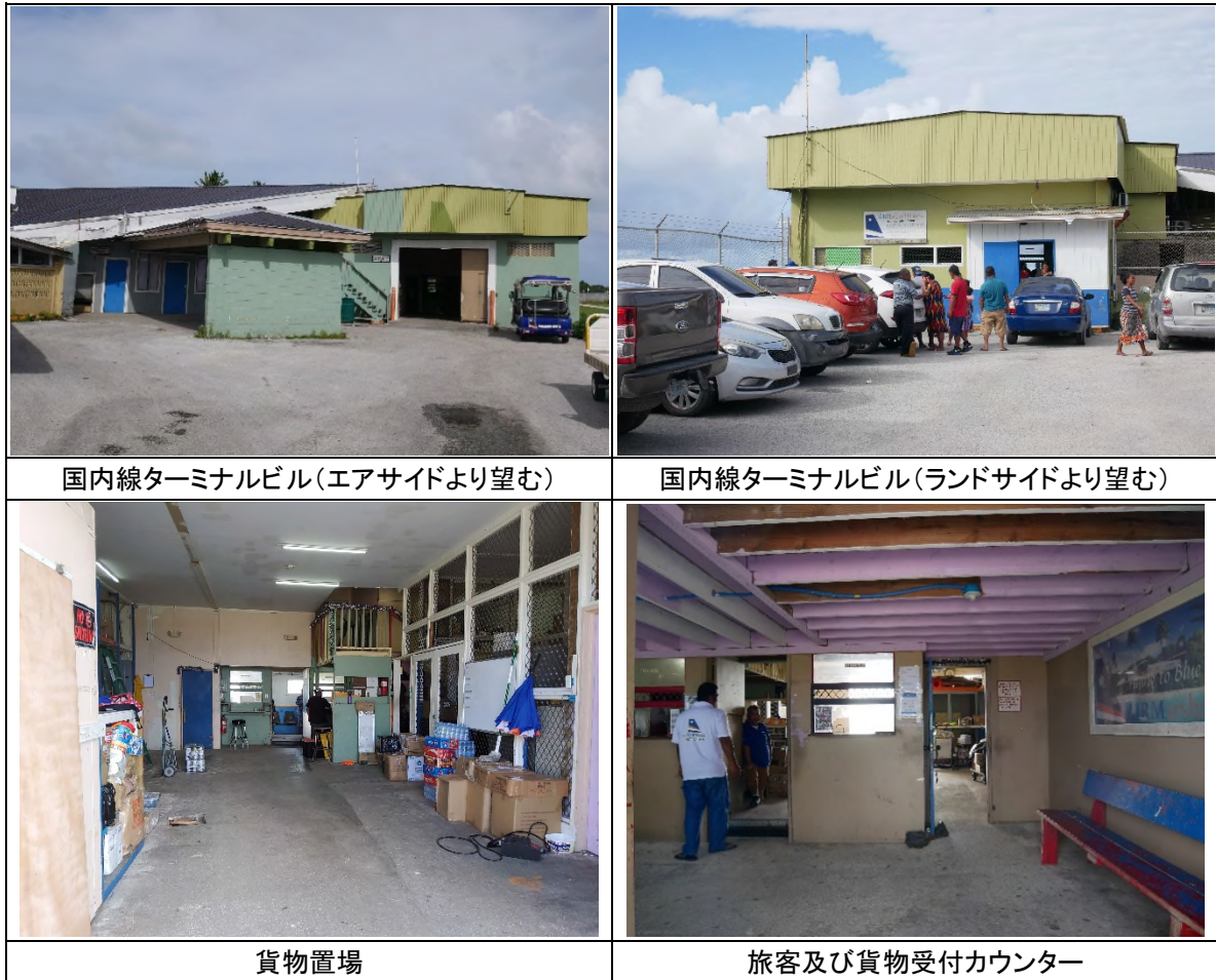
図 4-1-16 国内線ターミナルビルの現状
