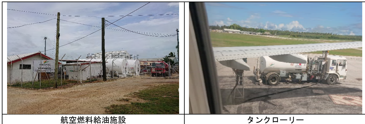
図 4-2-12 ファアモツ国際空港の航空燃料給油施設
