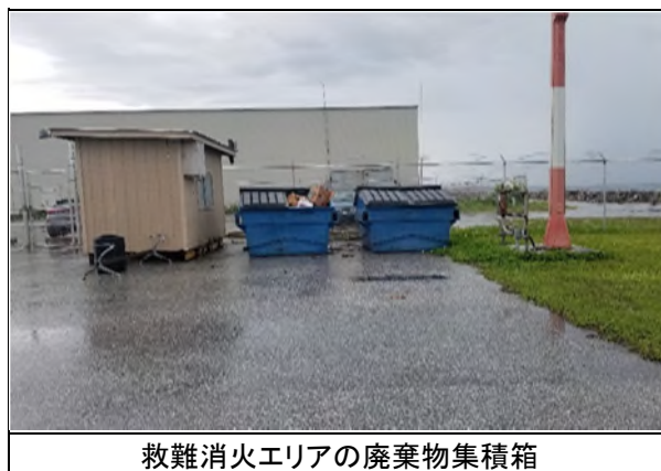
図 4-1-13 救難消火エリアの廃棄物集積箱
