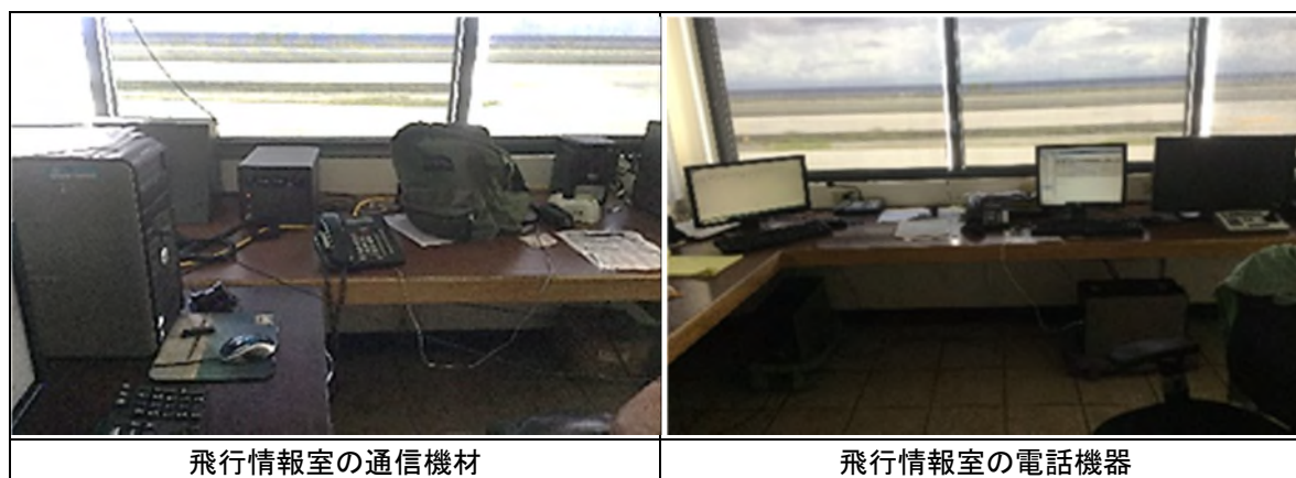
図 4-1-6 救難消防施設 2 階の飛行情報業務室の通信機材
