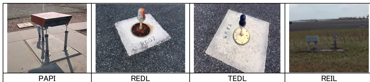
図 4-1-5 既設の航空灯火システム
