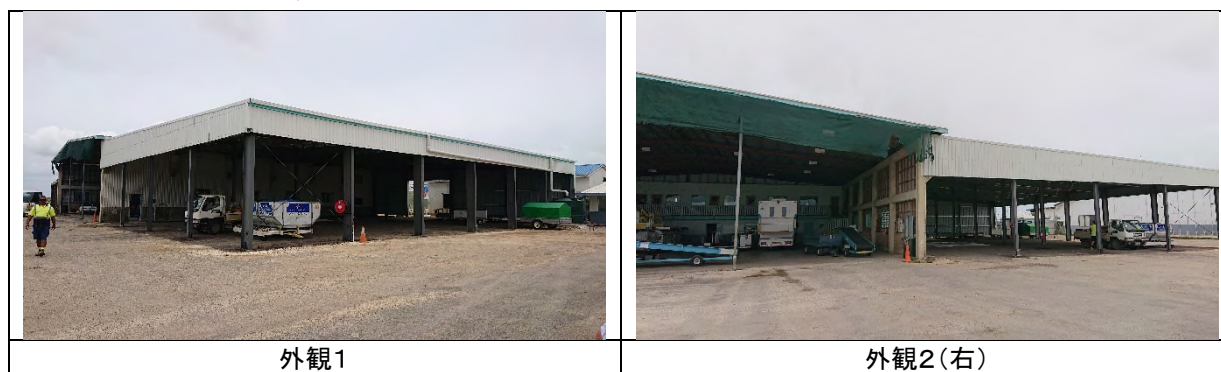
図 4-2-19 国際線貨物ターミナルの現状
