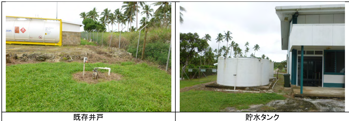
図 5-2-13 給水施設の現状
