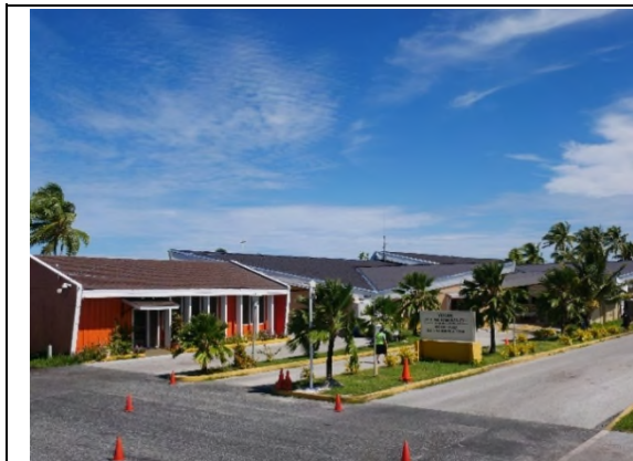
ターミナルビル外観（エアサイドより望む）
