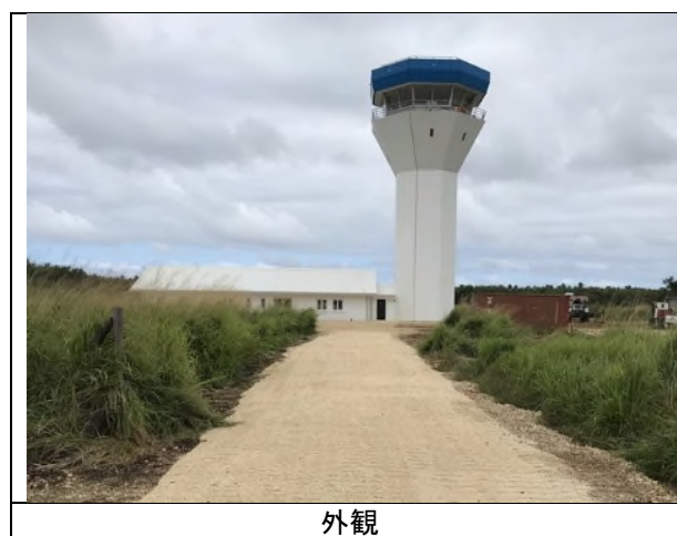
図 4-2-20 管制塔の現状
