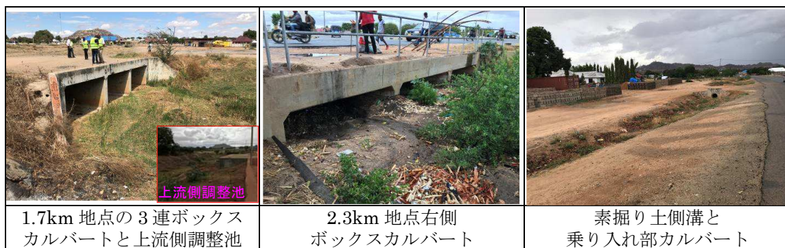
写真 1: 区間 2-2 の主な排水施設
