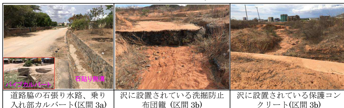
写真 2: 区間 3 の主な排水施設
