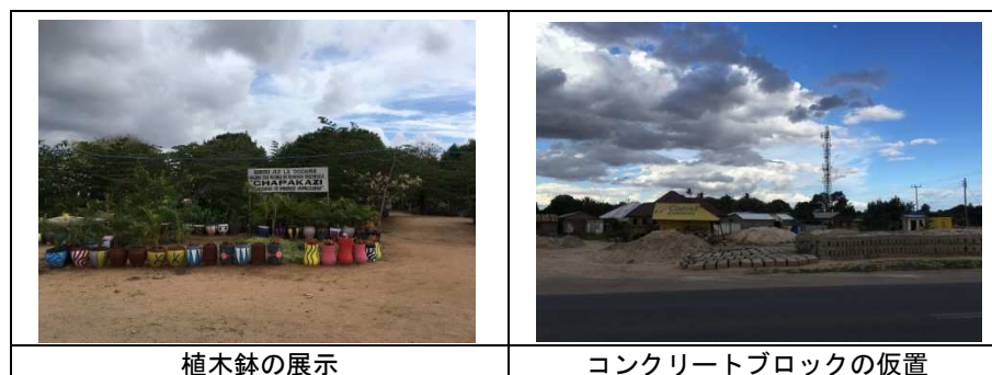
写真 5: 調査時現況(区間 2-2)
