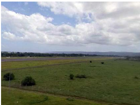
写真 3.9 管制塔から見た滑走路 11 端
