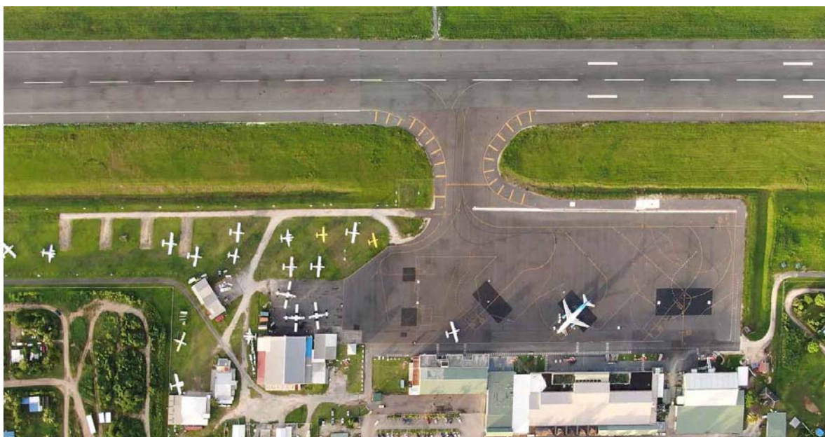
写真 3.3 既存エプロンの状況
