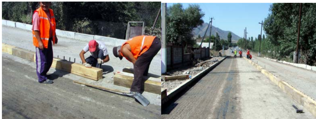
Состояние установки опалубки 2010года
