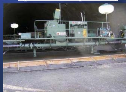
Разравниватель бетона (ровная поверхность)
