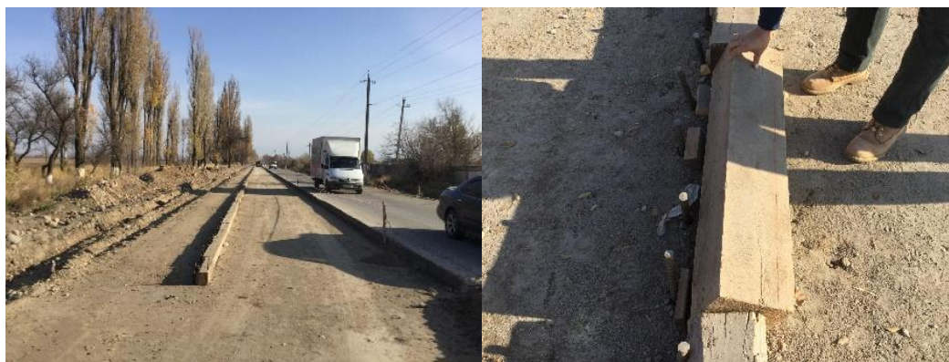
Состояние завершенной установки опалубки для строительства на 2-полосе)
