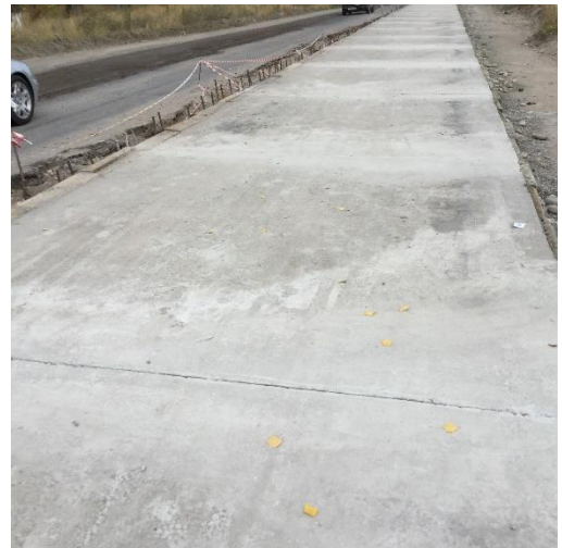
Ремонт дорожного покрытия цементным раствором
