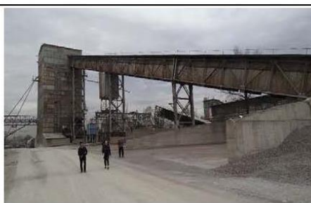
Фото 2: бетонный узел, Хранилище заполнителей
