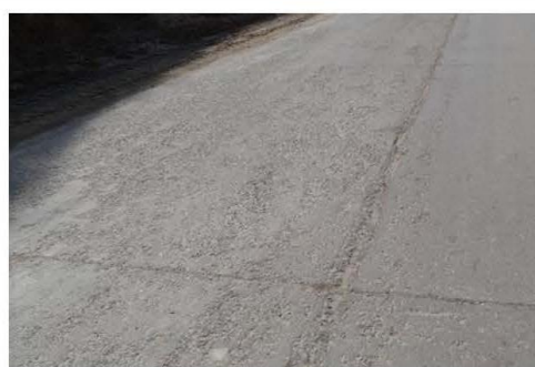
Фото 2: Состояние поверхности Управления консистенции и работы человеческих ресурсов неадекватны
