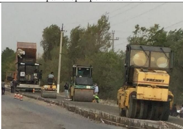
Выравнивание, уплотнение и прокатка
