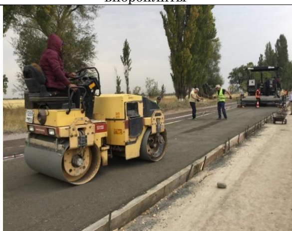
Состояние уплотнения дорожного покрытия маленьким катком
