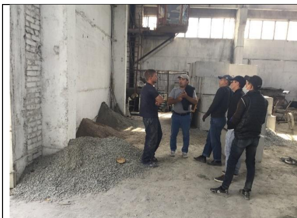
Обсуждение бетонной смеси
