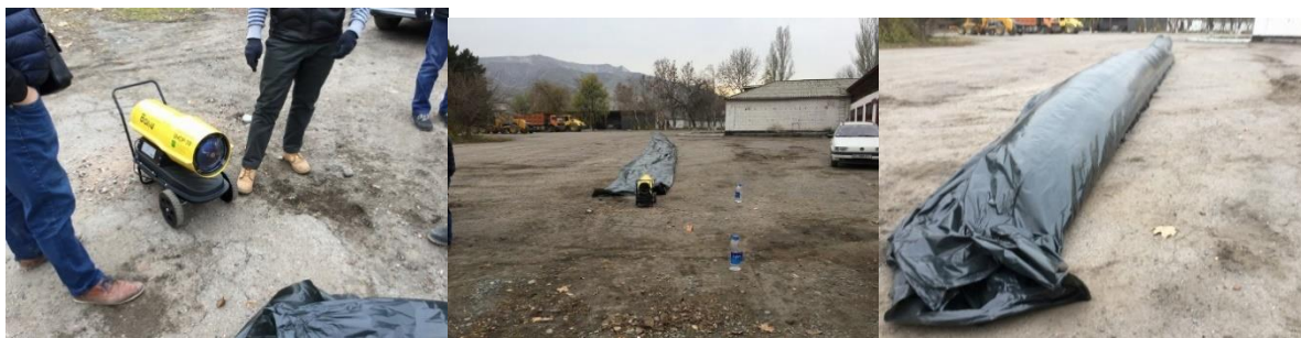
Состояние пробного отверждения теплоснабжения с использованием струйного нагревателя, который может быть реализован на месте
