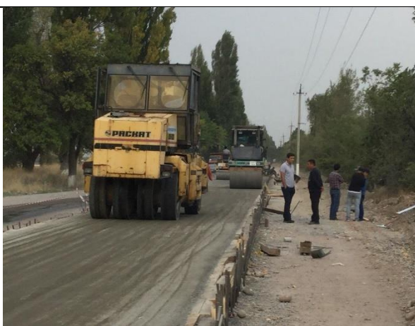
Чистовая прокатка пневмокатком
