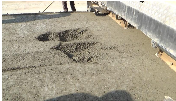
Углубления после уплотнения АУ
