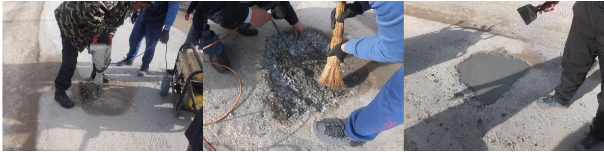
Состояние ремонта дефектов на 1-полосе
