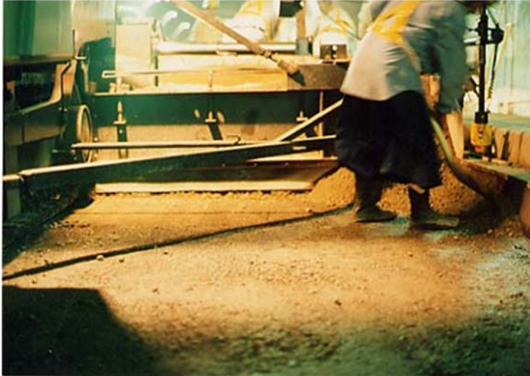
スコップマン作業状況
