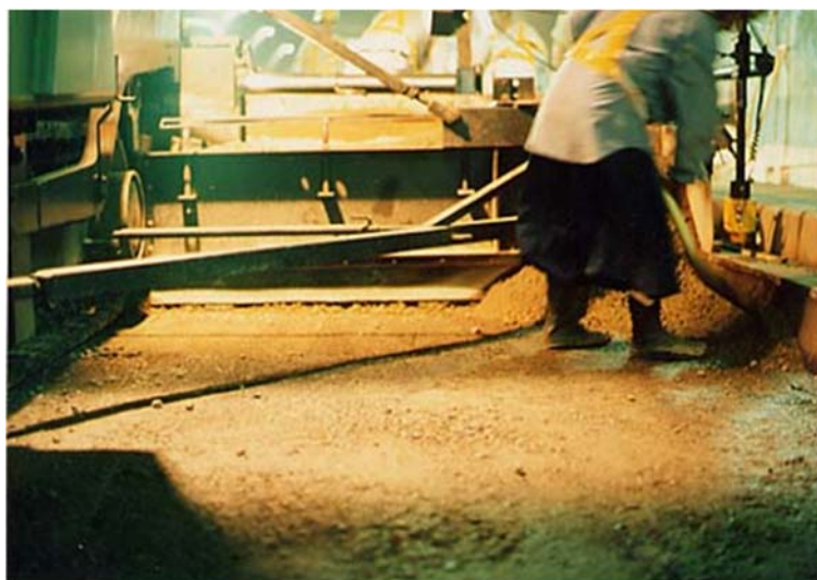
スコップマン作業状況
