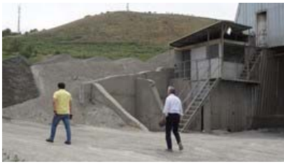
生コン操作室前
