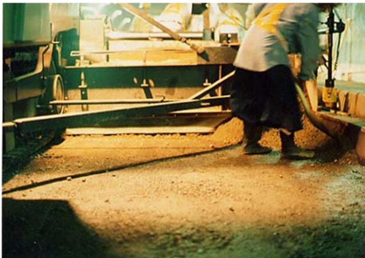
スコップマン作業状況
