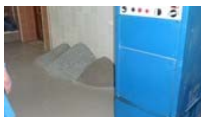
室内対応の材料ヤード
