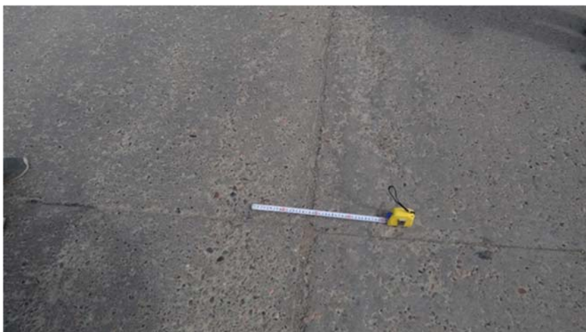
④ 比較的良好な縦継目（少し粗い）と横収縮目地
