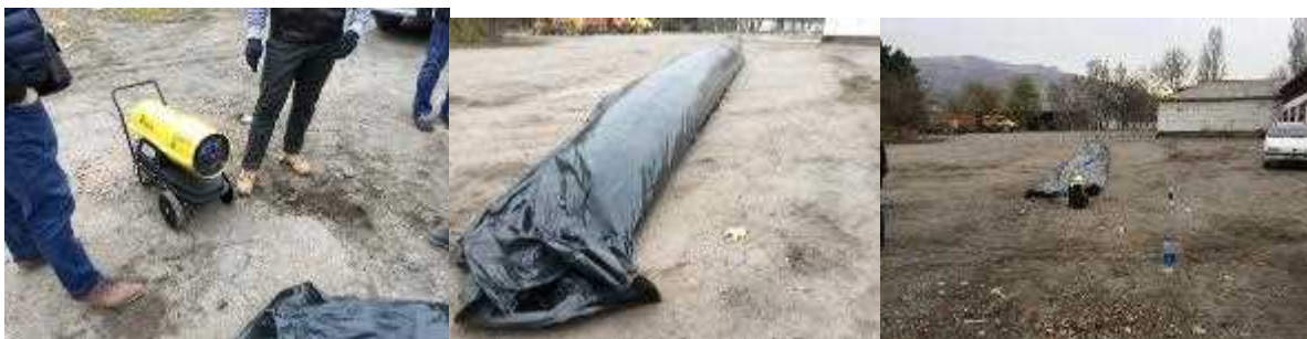
現地で実施可能なジェットヒータを活用した給熱養生の試行状況
