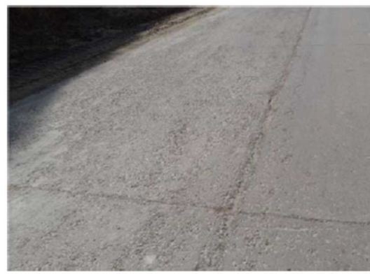
写真2：表面仕上がり状況 コンシステンシー管理・人力補助作業不十分
