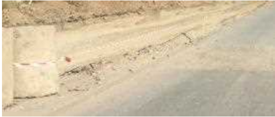
交通車両への注意喚起のためのテープ設置
