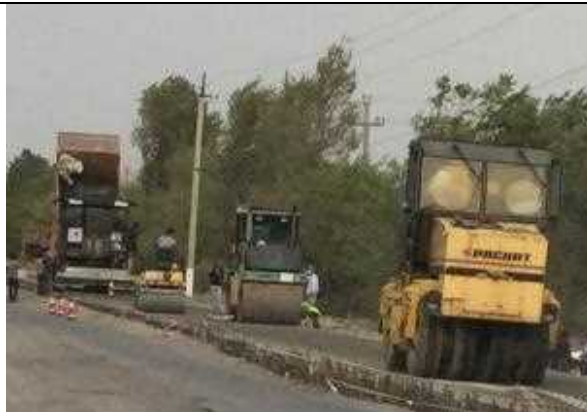
敷均し・締固め・転圧状況
