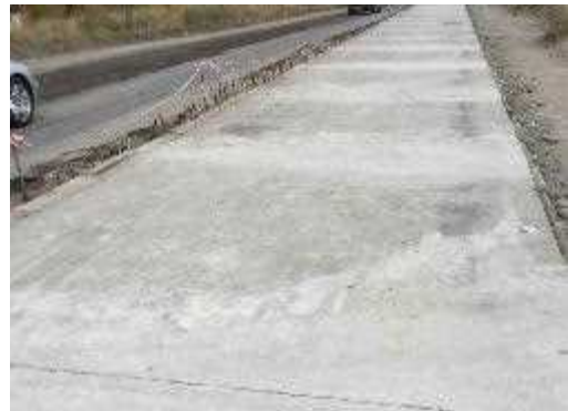
セメントモルタルによる路面補修
