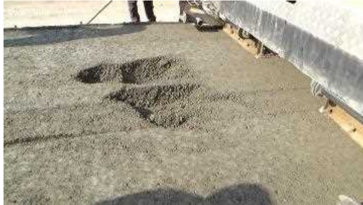
AF 締固め後の空洞
