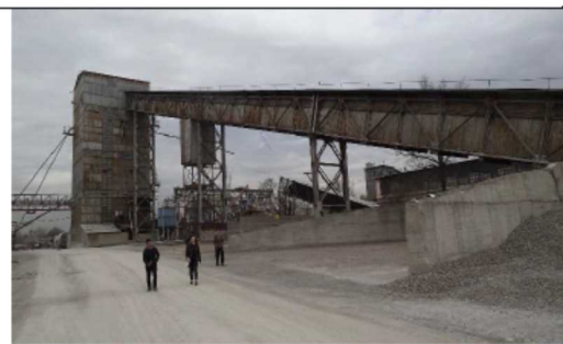
写真2：パン型パッチャープラント、骨材ストックヤード
