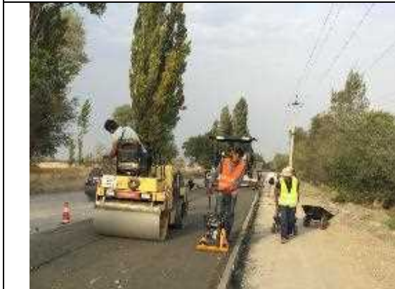
小型ローラ・ビブロプレートの細部転圧
