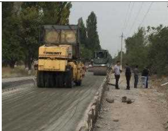
タイヤローラによる仕上げ転圧状況
