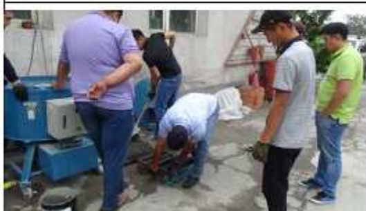
写真3: 室内ミキサによるコンクリート製造
