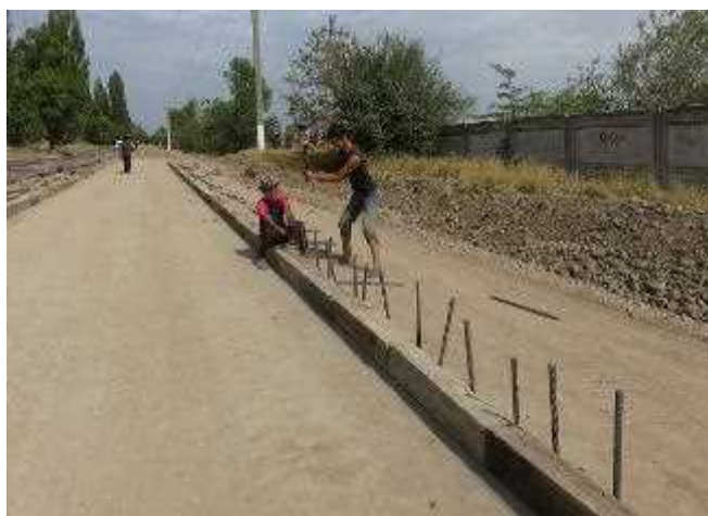
型枠設置状況
