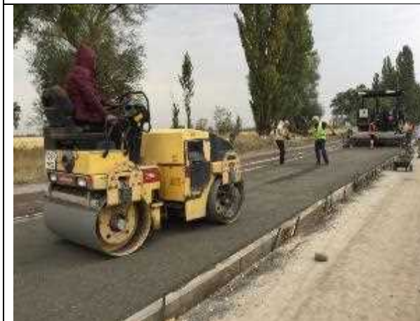
小型ローラによる路面細部の転圧状況
