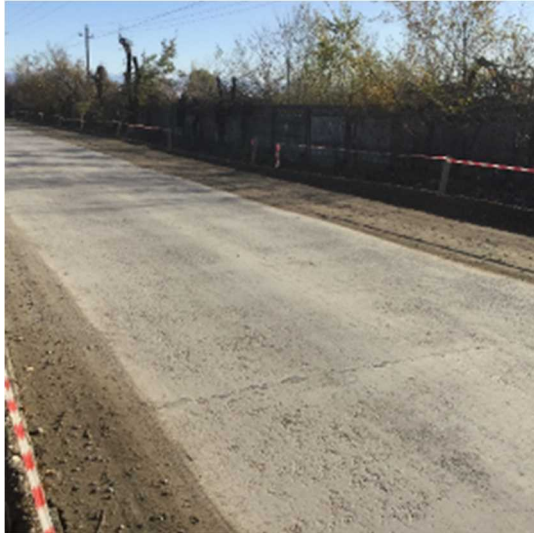
安定した良好な路面状況
