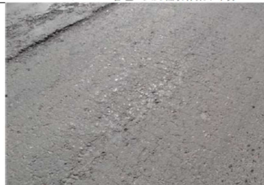
写真4：ティアリングクラック RCCのコンシステンシー不良（水分過多）
