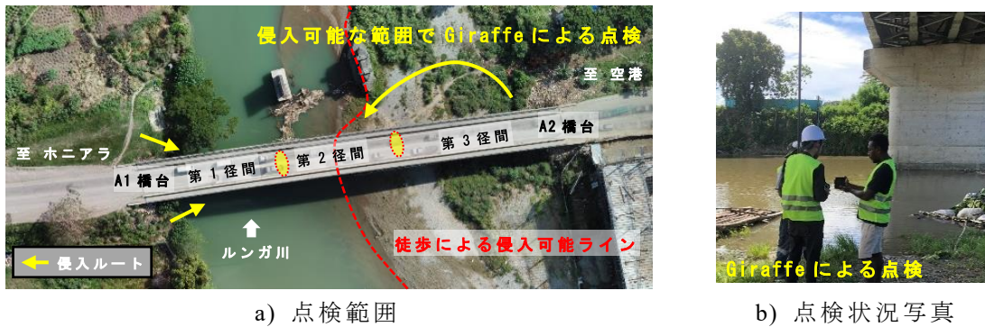
図 3-71 点検範囲と点検状況写真
