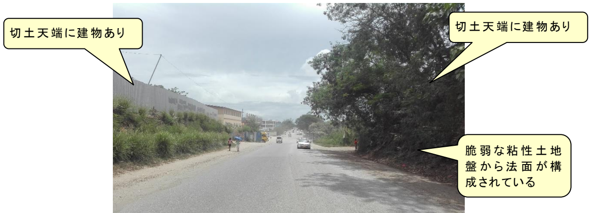
図 3-57 STA. 4+540～4+680 の切土区間
