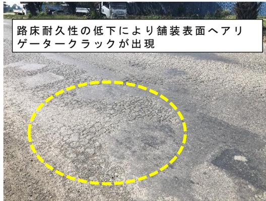
図 3-13 路床耐久性の低下による舗装表面の損傷
