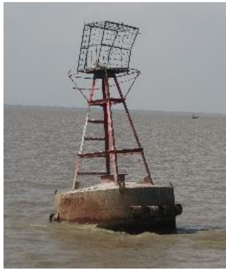
既存灯浮標 (状態が良いため、補修対象)
