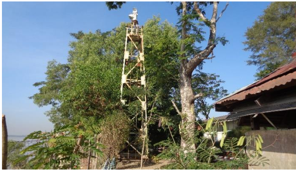
モンキーポイント灯台 (陸側から撮影、状態悪いため建替え)
