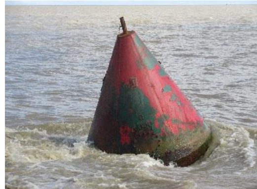
既存灯浮標 (状態が悪く灯器が無いため、交換対象)
