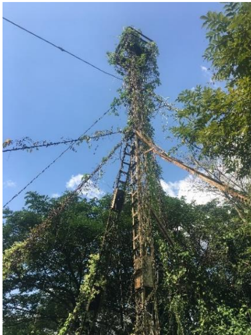
既存タンリンポイント灯台 前灯 (状態が悪いため建替え)
