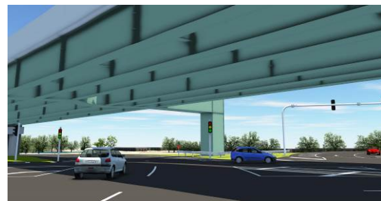
d) 鋼製橋脚の視距への影響確認
