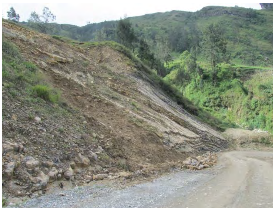
Figura 6 — Kolapsu relasiona ho corte de taludes
