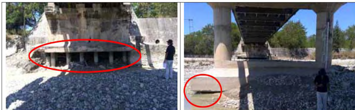
Imagem situasaun abut no pilar ne'ebe hetan estraga
