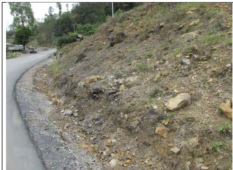
Figura 16 — Afloramento da zona cortada
