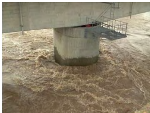
Figura 9 — Fenomena hidrauliku iha pilar ponte (Ezemplu iha Japaun)
