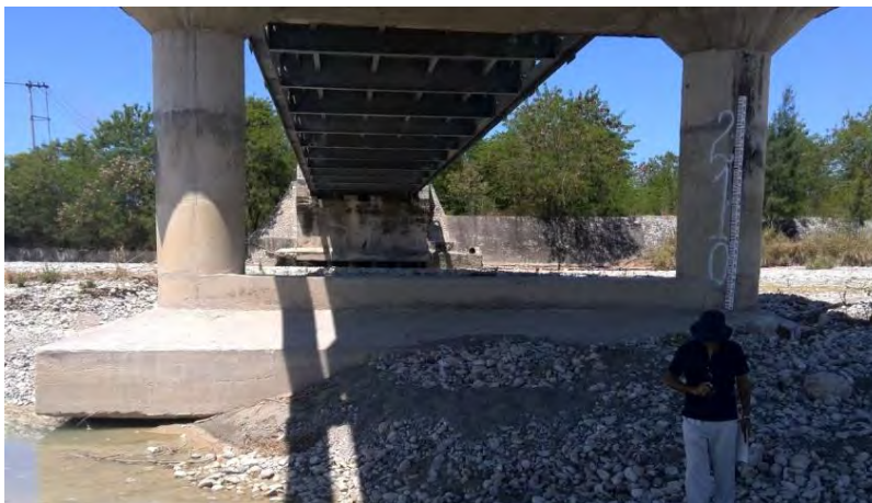
Figura 3 — Pilar Ponte Sahen 2017
