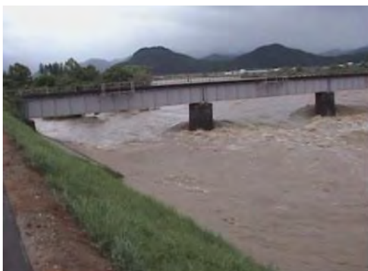
Figura 9 — Fenomena hidrauliku iha pilar ponte (Ezemplu iha Japaun)
