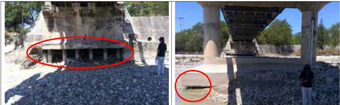
Imagem situasoun abut no pilar ne'ebe hetan estraga
