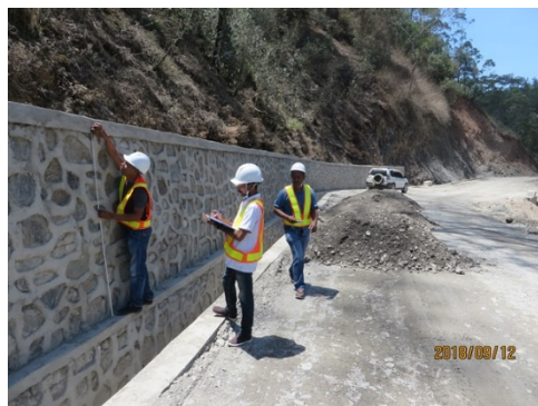
Humboe-Letefoho 緊急工事 (STA 13 km) における石積み擁壁に対してチェックリストを使用する OJT (2018 年 9 月 12 日)
