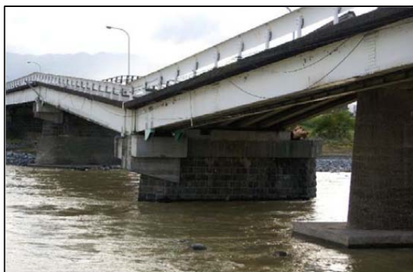
図 2.25 「洗堀による橋梁の被災事例（日本）」
