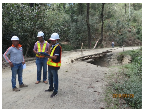
Humboe-Letefoho 緊急工事 (STA 18 km) における横断排水施設に対してチェックリストを使用する OJT (2018 年 6 月 28 日)
