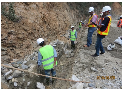
Humboe-Letefoho 緊急工事 (STA 13 km) における石積み擁壁に対してチェックリストを使用する OJT (2018 年 6 月 28 日)
