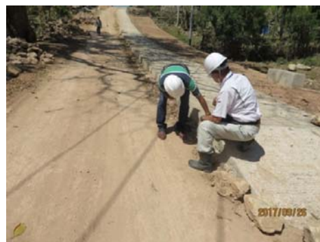
A08 道路の Iliomar 及び Lospalos 現場 (9 パッケージの No.1) におけるコンクリート舗装に対して品質管理の OJT (2017 年 9 月 26 日)
