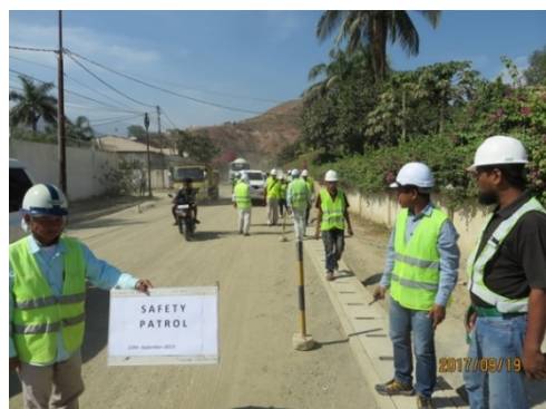
コモロ川上流新橋建設における安全パトロール（2017 年 9 月 19 日）
