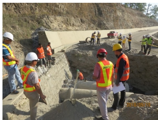
Ex-Japan 道路における横断排水施設敷設の安全パトロール (2018 年 9 月 19 日)
