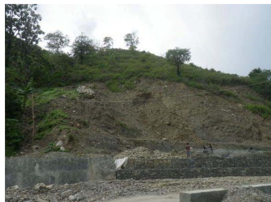
施工者による対策工事
