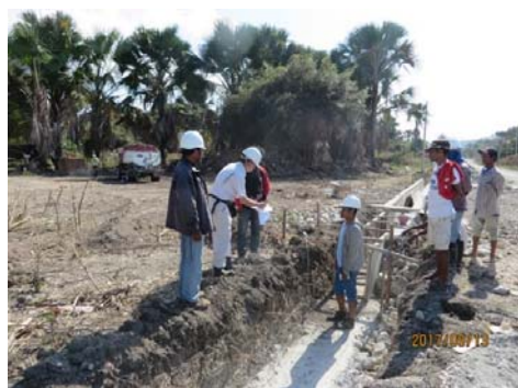
A14 道路の Betano-Dotic 現場 (9 パッケージの No.4) における排水管に対して品質管理の OJT (2017 年 9 月 30 日)
