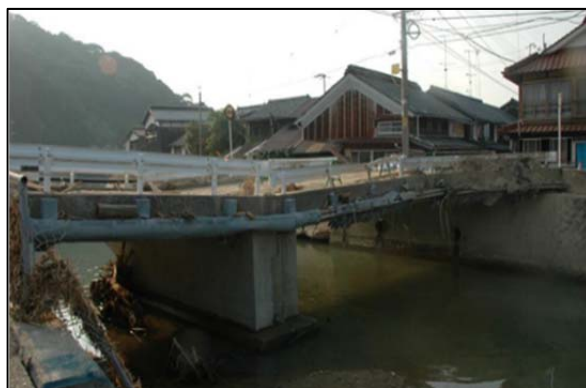
図 2.25 「洗堀による橋梁の被災事例（日本）」
