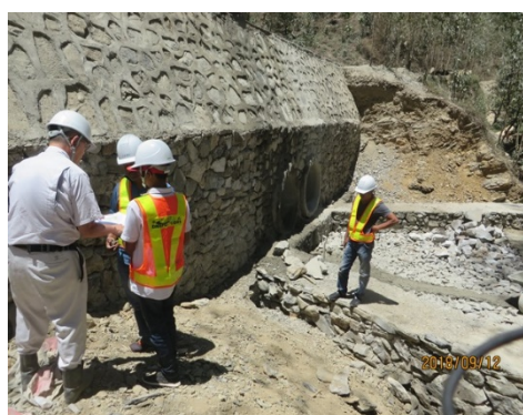
Humboe-Letefoho 緊急工事 (STA 18 km) における横断排水施設に対してチェックリストを使用する OJT (2018 年 9 月 12 日)
