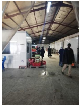
冷蔵倉庫の内部
