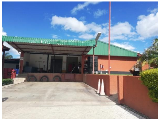
地場の販売代理店の冷蔵倉庫
