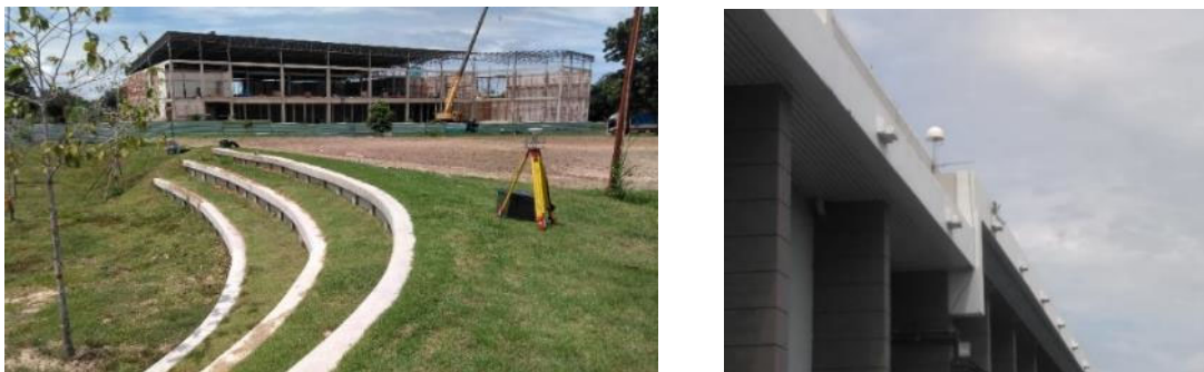
図 34 現場作業風景 (左)と SKP 内の CORS K010 外観 (右)
