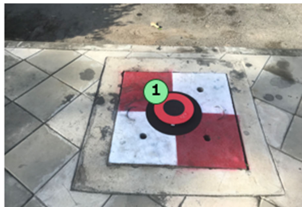
図 4 GNSS マーカーの設置状況
