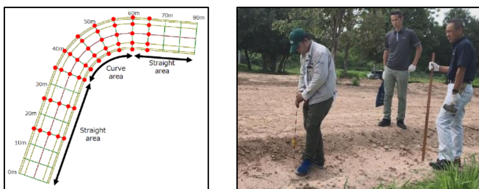
図 48 左：基準杭の位置、右：水平位置決め作業
