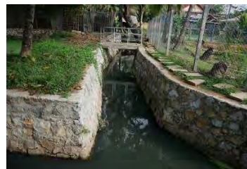
AFDによる 排水溝
