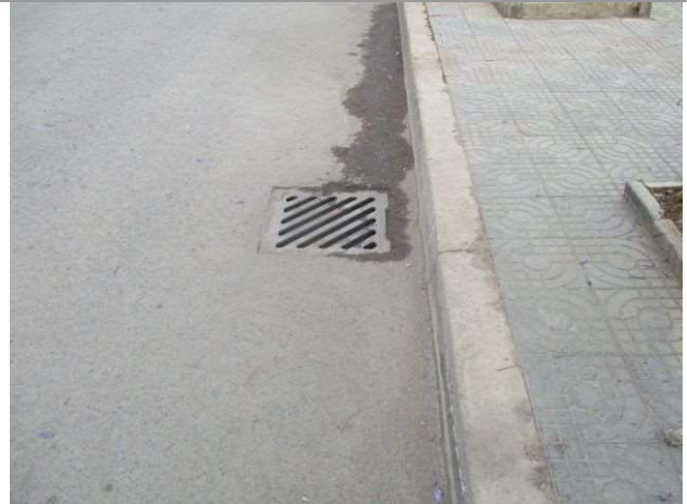
写真 14：車道上の排水柵
