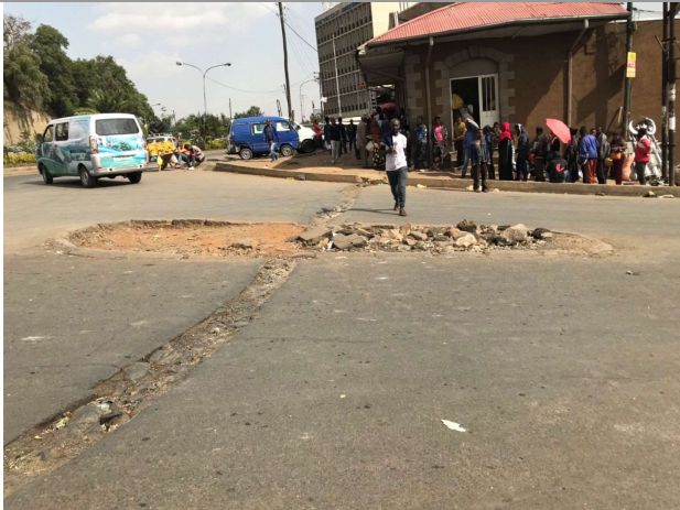
写真 13：補助幹線道路(SAS)のオーバーレイ状況
