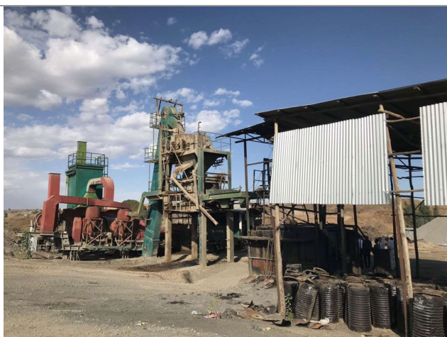
写真 7：アスファルトプラント
