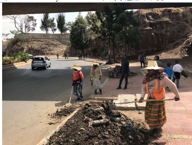
写真 12：主要幹線道路(PAS)の排水施設清掃状況
