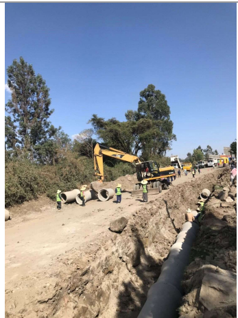
写真16: 地区内街路(LS)における道路公社の工事現場
