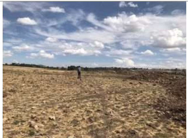
写真6：新規道路公社機材管理センター建設予定地
