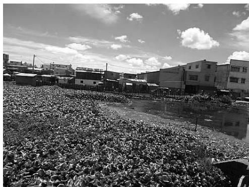
Photo 8 La capacité du bassin a diminué en raison de la végétation
