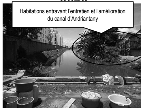
Photo 7 Habitation interférant avec les travaux d'entretien
