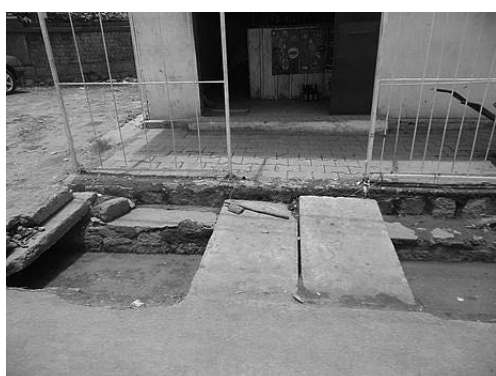
Photo 6 Caniveau enterré en raison d'une nouvelle construction
