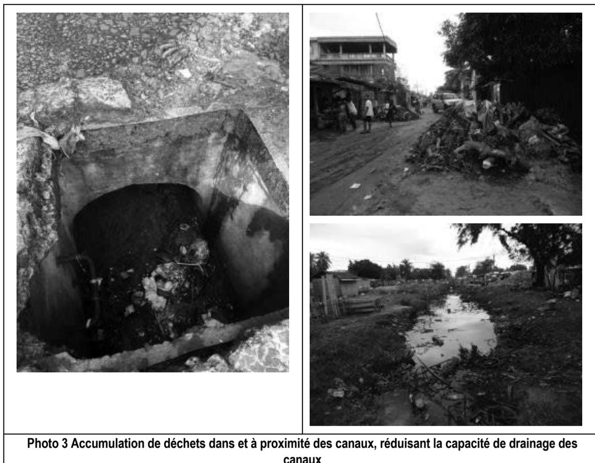
Figure 21.2.3 Exemples de causes de la réduction de la capacité de drainage
