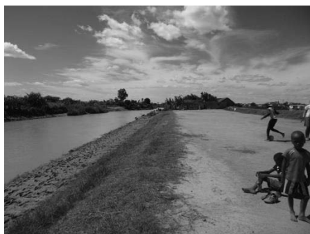
Photo 1 Digue réparée (cette digue a été rehaussée après les inondations de 2015)
