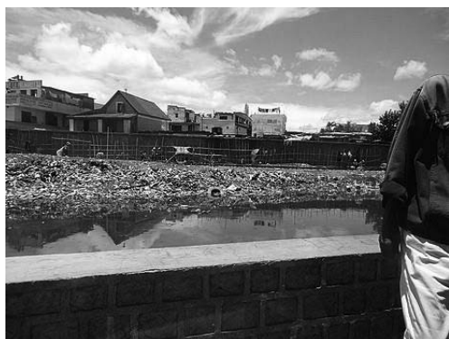
Photo 4 Accumulation de déchets dans le canal
