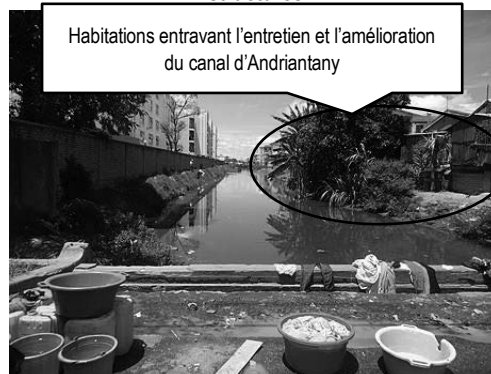
Photo 7 Habitation interférant avec les travaux d'entretien
