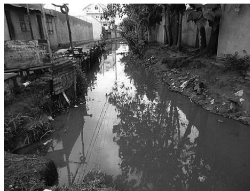
Photo 9 Dégradation des canaux existants
