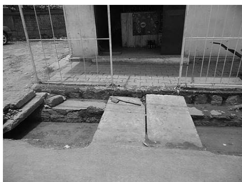
Photo 6 Caniveau enterré en raison d'une nouvelle construction
