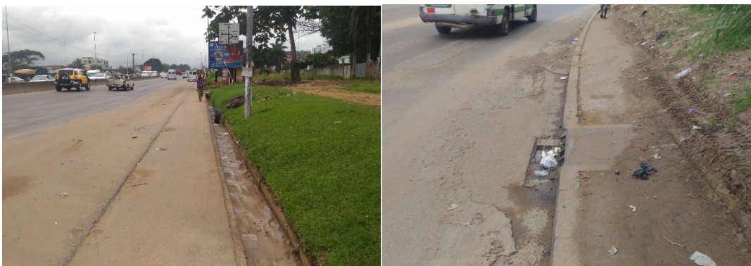
Figure 3.1.10 Installations de drainage dans lesquelles se sont amassés sédiments et déchets
