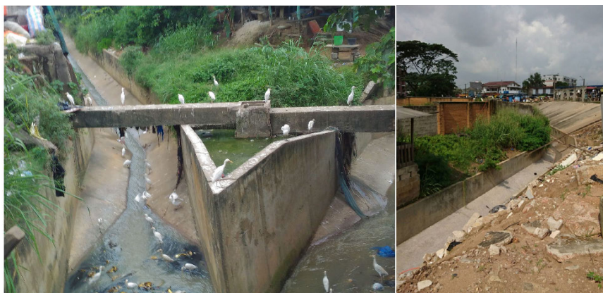
Figure 3.1.7 Rigole en U parallèle au boulevard Mitterrand (cours d'eau)
