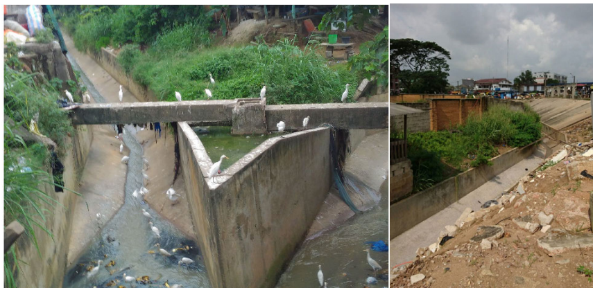
Figure 3.6 Rigole en U parallèle au boulevard Mitterrand (cours d'eau)
