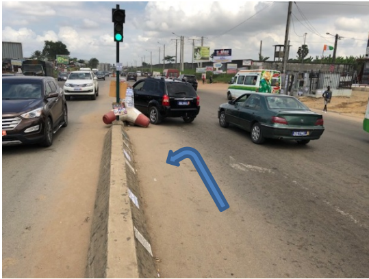
Des voies de tourne-à-gauche sont installées.
