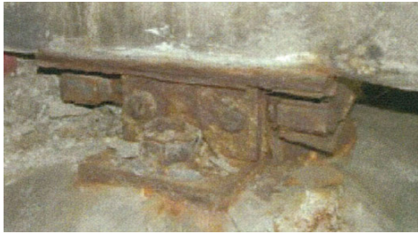
図 12.2.7 鋼部材の損傷と判定区分の例（判定区分Ⅲ）
