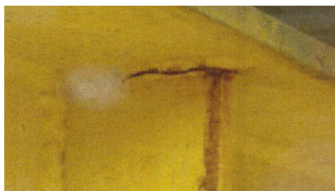
図 12.2.6 鋼部材の損傷と判定区分の例（判定区分 II）
