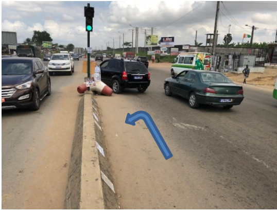
左折車線が設置されている
