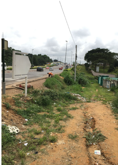
図 3.1.9 警察学校前交差点南側の現況地盤の洗堀状況
