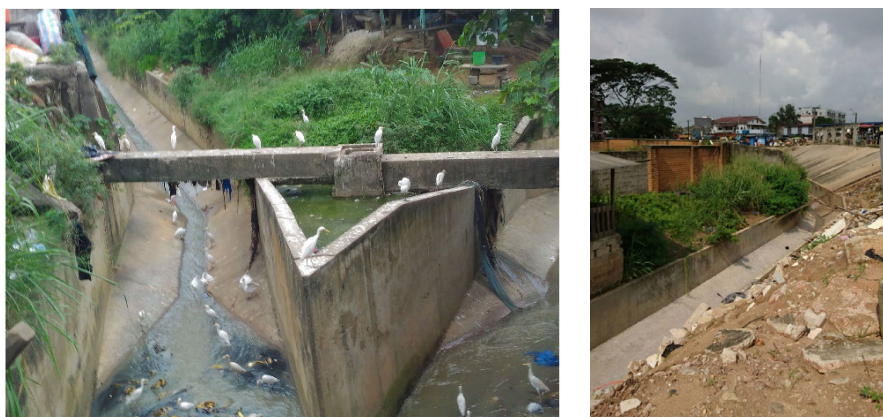
図 3.6 ミッテラン通りに並行する U 型水路（河川）
