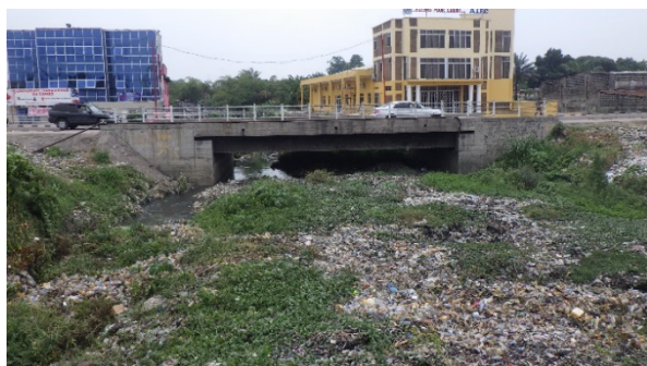
Pont sur la rivière Yolo traversant le boulevard Lumumba situé en aval de l'avenue de l'Université observé le 14 octobre 2018
