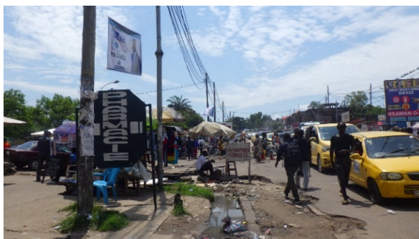
Fossé existant non-fonctionnel par débris au drainage du PK6,2 km à côté gauche
