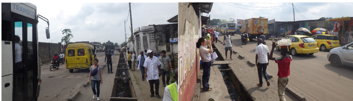
Fossé latéral au gradient variable installé de PK7,0 à PK8,0 Km
