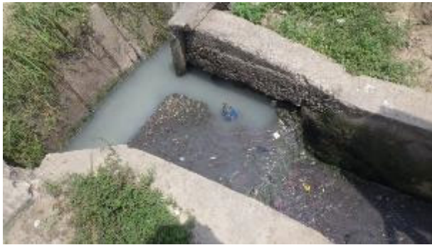
Valve à côté droit à PK0,12 km le 16 novembre 2018
