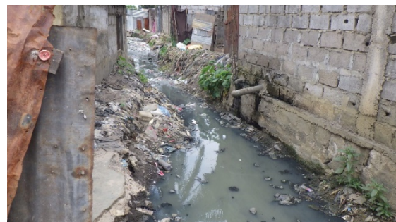
En aval (3,0 m de largeur et 1,0 m de profondeur en moyenne) entre les bâtiments à PK3,95 km
