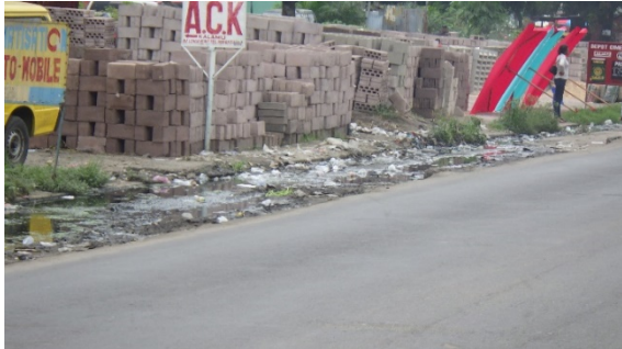
Fossé latéral existant non fonctionnel en raison d'une pente dénivelée inadéquate à PK1,2 km à RHS (à côté droit/Right Hand Side)
