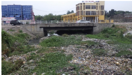
Fossé latéral existant non fonctionnel en raison d'une pente dénivelée inadéquate à PK1,2 km à RHS (à côté droit/Right Hand Side)
