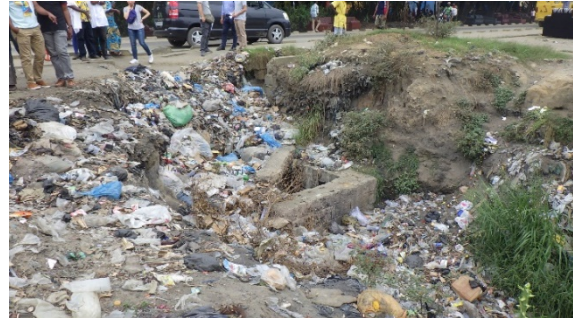
Fossé et tranchée enfouis par des débris au croisement de drainage à PK2.2 km à LHS (à côté gauche/Left Hand Side)
