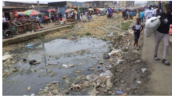
Flaque d'eau avec débris dans l'actuelle route à environ PK4,0 km
