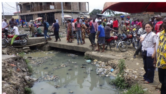
Fossé existant traversant d'une largeur de 3,5 m à PK3,96 km environ
