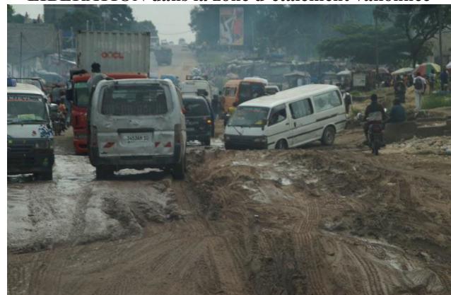
BY-PASS dans la zone d'étalement collinaire
