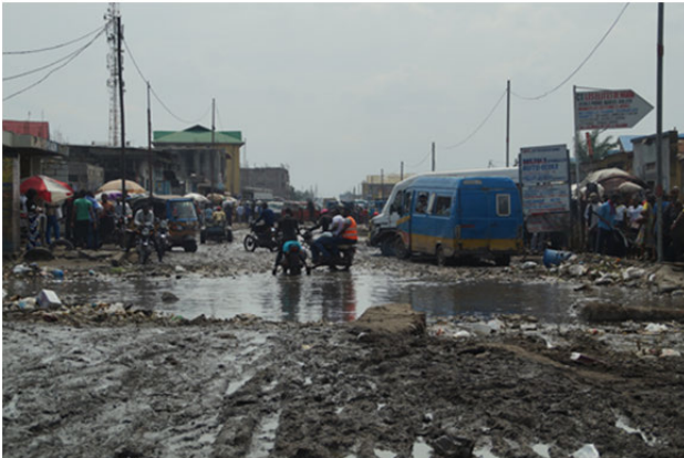
UNIVERSITE dans la zone d'étalement plate
