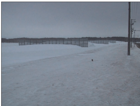
Фото 2-2-2.1 Пример установленных решетчатых снегозадерживающих заборов (слева: на Хоккайдо; справа: штат Вайоминг, США)
