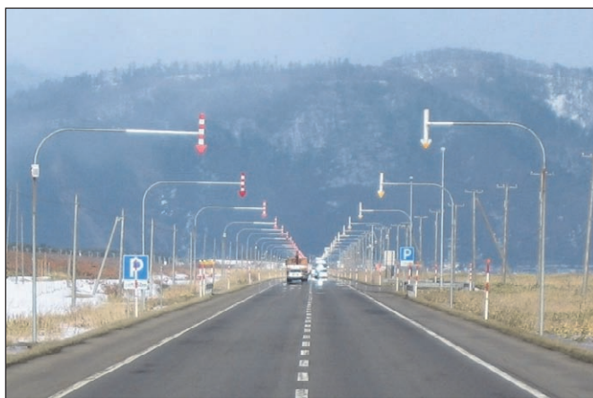
Фото 2-2-2.2 Пример установленных сигнальных вех (меры для зрительного ориентирования)
